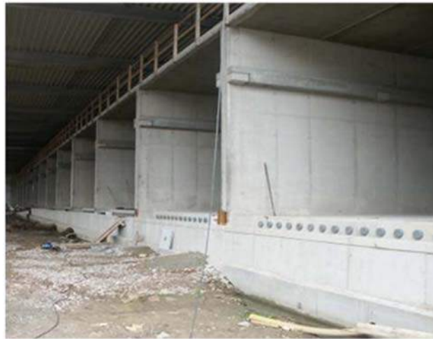
Εικόνα 7-13: Υπό κατασκευή σύστημα κομποστοποίησης σε τούνελ της εταιρίας Horstmann GmbH στο Münster της Γερμανίας.
