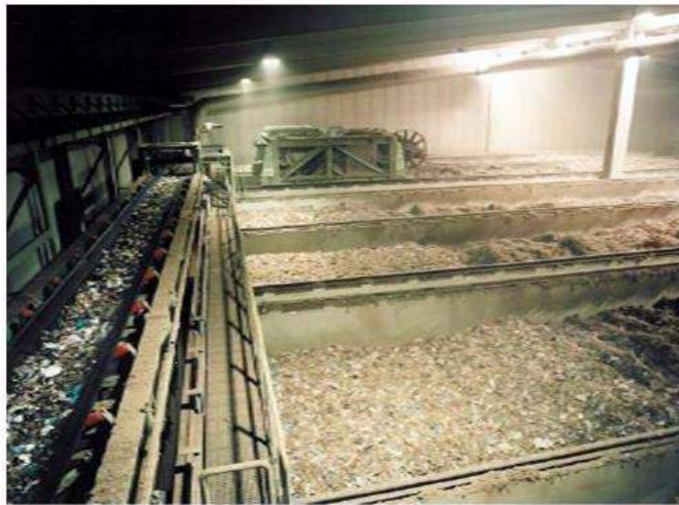
Εικόνα 7-14: Σύστημα κομποστοποίησης σε δεξαμενές.
