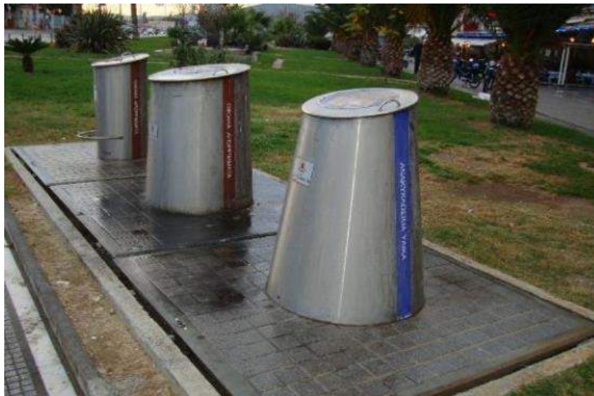
Εικόνα 7-4: Σύστημα βυθιζόμενων κάδων
