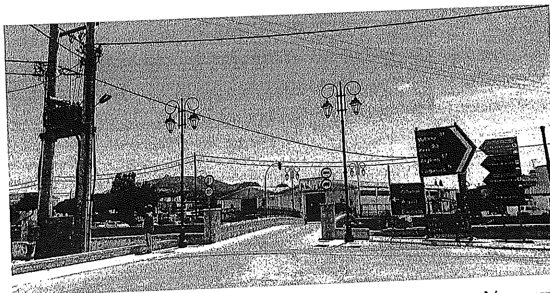
Εικόνα 3: Όψη του οδοστρώματος της Ενετικής Γέφυρας του Αγίου Χαραλάμπη μετά τις εργασίες αποκατάστασης και ενίσχυσης της κατά το έτος 2014.
