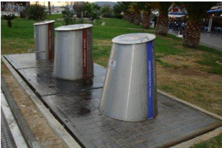
Εικόνα 7-4: Σύστημα βυθιζόμενων κάδων
