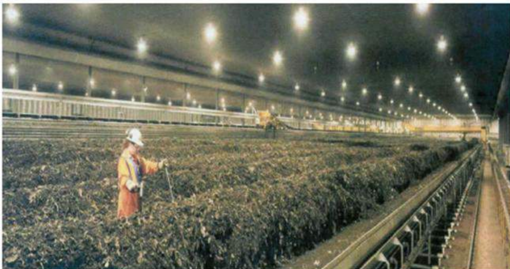
Εικόνα 7-15: Τράπεζα κομποστοποίησης της εταιρίας Bedminster (εδώ χρησιμοποιείται για τη φάση της ωρίμανσης με χρόνο παραμονής 3-5 εβδομάδες).
