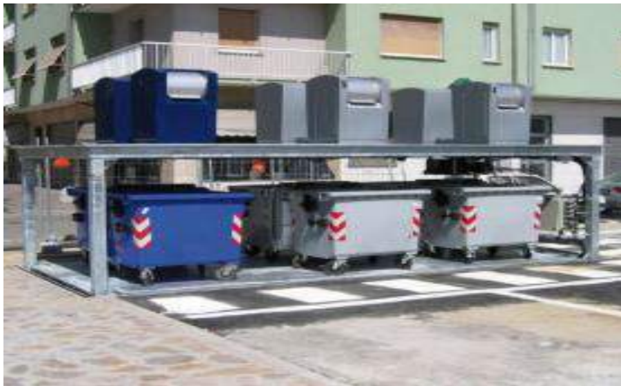
Εικόνα 7-5: Σύστημα βυθιζόμενων κάδων
