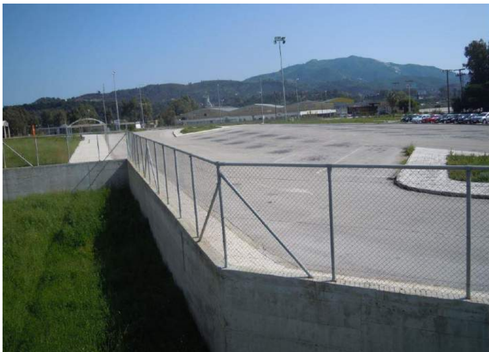
Φ7: Χώρος ζήαθμεσζης ασηοκνήηων
