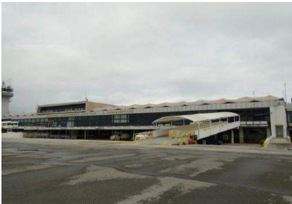
Φ13: Παλαιότερο κτίριο αεροσταθμού
