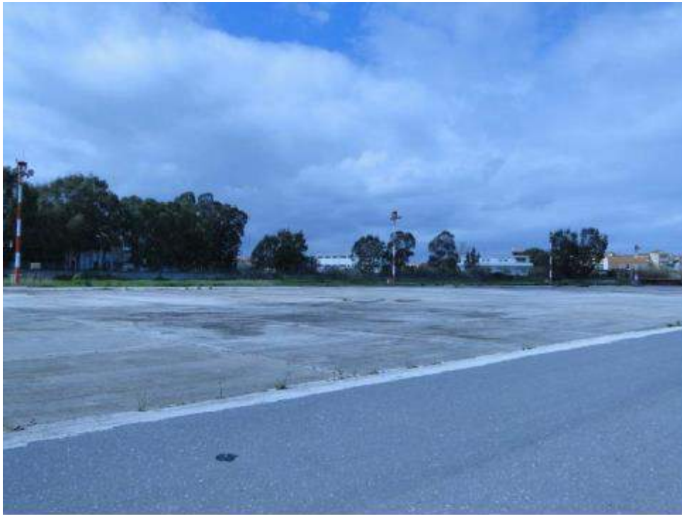
Φ23: Δάπεδο ελαφρών αεροσκαφών
