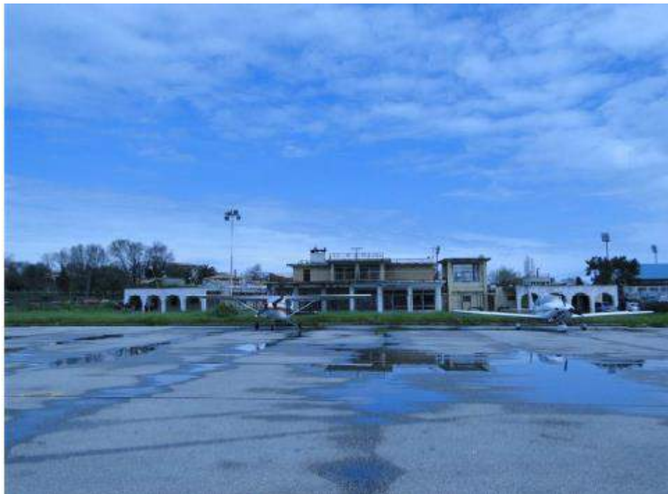
Φ26: Κτίριο παλαιού αεροσταθμού (προς κατεδάφιση)
