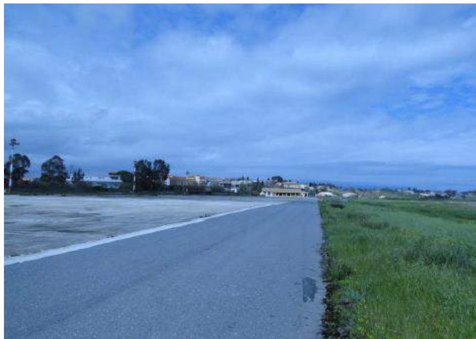
Φ24: Δάπεδο ελαφρών αεροσκαφών
