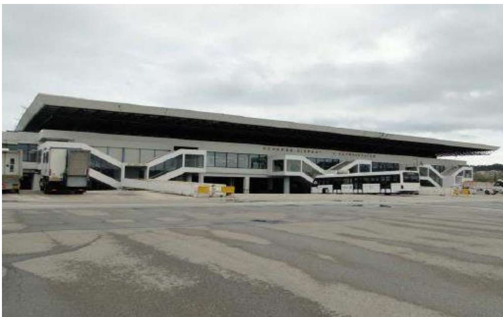
Φ12: Νέο κτίριο αεροσταθμού
