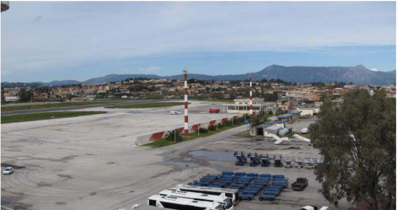
Φ1: Βόρειο τμήμα δαπέδου στάθμευσης, χώρος στάθμευσης επίγειου εξοπλισμού. Στο βάθος διακρίνεται ο πυροσβεστικός σταθμός
