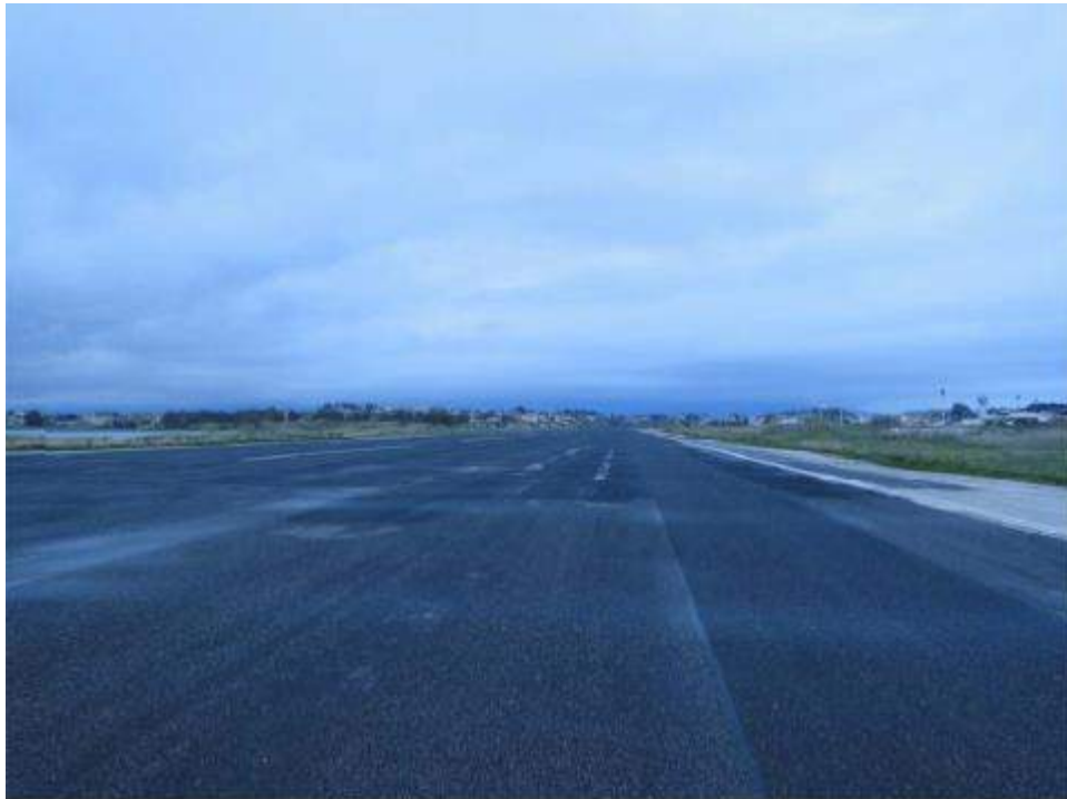
Φ19: Άποψη του διαδρόμου προς άκρο 17 (Βόρειο άκρο)
