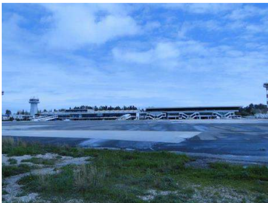
Φ14: Άποψη κτιρίων αεροσταθμού + Π.Ε.Α.
