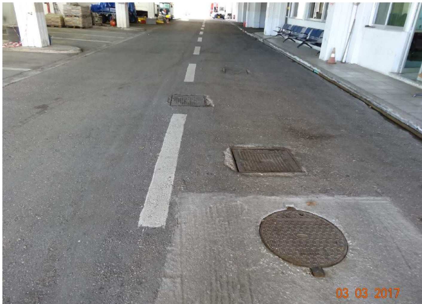
Εικόνα 1: Κεντρική δεξαμενή συλλογής λυμάτων και αντλιοστάσιο αεροσταθμού.
