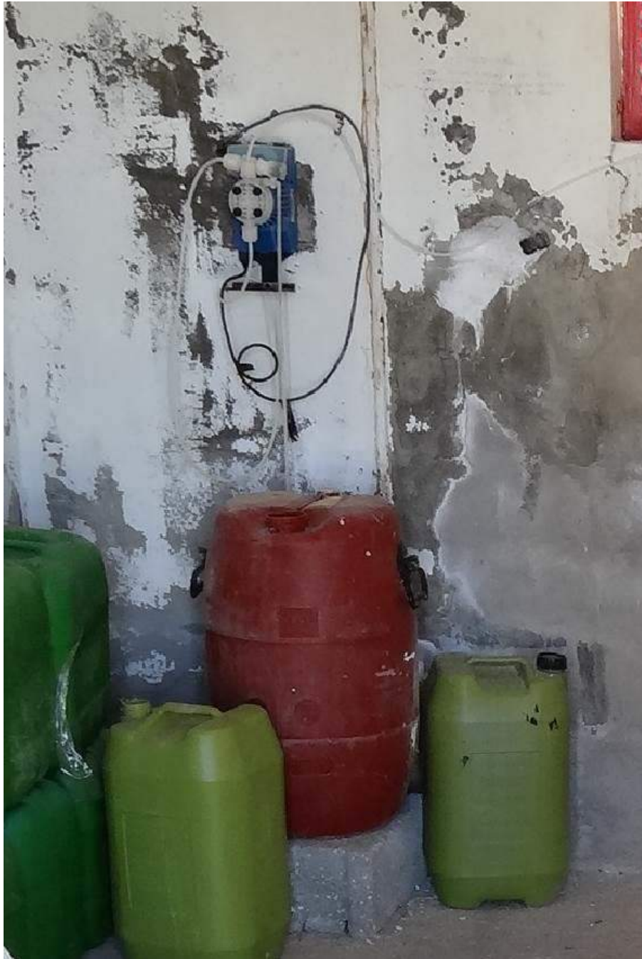
Εικόνα 11: Αντλία δοσομετρικού συστήματος υποχλωριώδους νατρίου, εντός του οικίσκου της ΕΕΛ, για την διοχέτευσή του στην δεξαμενή χλωρίωσης. Διακρίνονται τα βαρέλια αποθήκευσης του υποχλωριώδους νατρίου.
