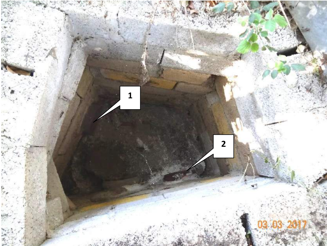
Εικόνα 19: Εσωτερικό φρεατίου φόρτισης του υπεδάφιου συστήματος διάθεσης των επεξεργασμένων λυμάτων ([1]: σημείο κατάληξης του αγωγού μεταφοράς των επεξεργασμένων λυμάτων, από την δεξαμενή χλωρίωσης, στο φρεάτιο φόρτισης και [2]: σημείο εκκίνησης του αγωγού υπεδάφιας διάθεσης των επεξεργασμένων λυμάτων, προς άρδευσης παρακείμενου της ΕΕΛ αλουλλίου με φυτεύσεις λιγούστρων).
