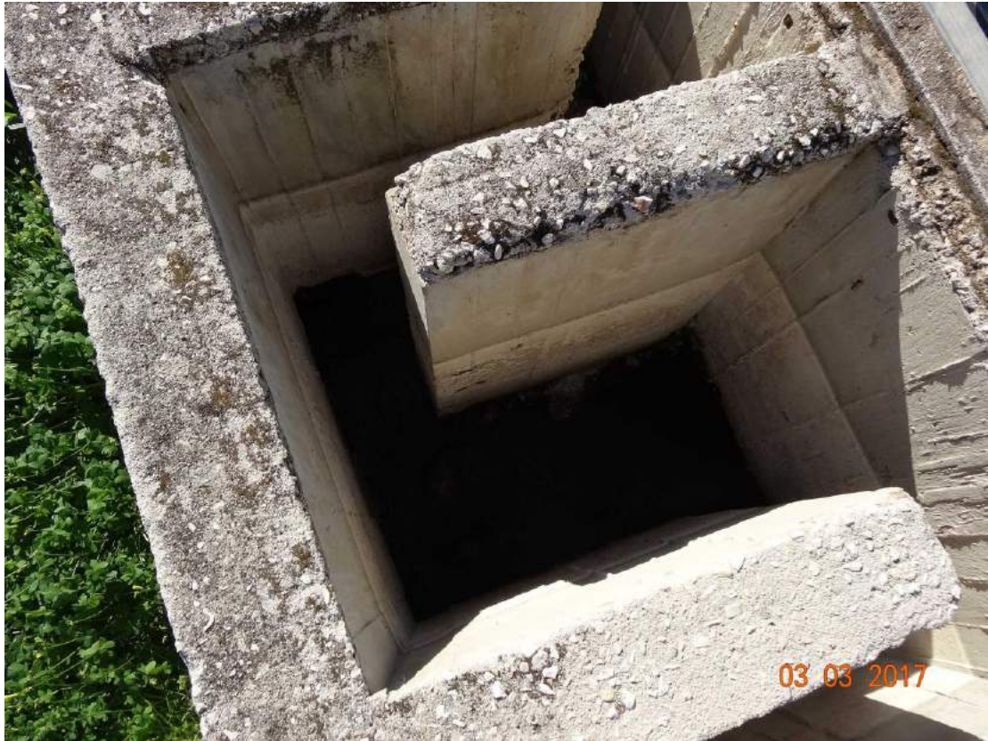
Εικόνα 15: Εσωτερικό τμήματος της μαιανδρικής δεξαμενής χλωρίωσης.
