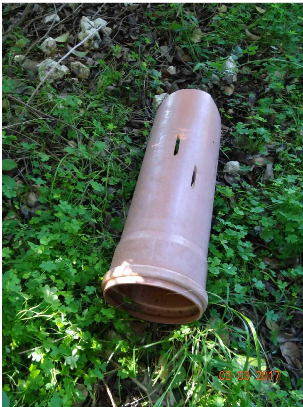
Εικόνα 5.2: Άποψη τμήματος του διάτρητου πλαστικού σωλήνα (PVC, Φ75) μέσω του οποίου γίνεται η υπεδάφια διάθεση των επεξεργασμένων λυμάτων, προς άρδευση φυτεύσεων, σε αλσύλλιο πλησίον της ΕΕΛ.
