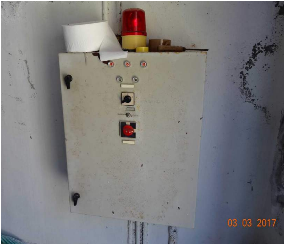
Εικόνα 10: Άποψη του πίνακα λειτουργίας του φυσητήρα αερισμού, στο εσωτερικό του οικίσκου της ΕΕΛ.
