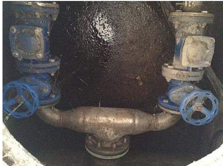
Εικόνα 3: Αντλίες, εντός του κεντρικού αντλιοστασίου λυμάτων του αεροσταθμού.
