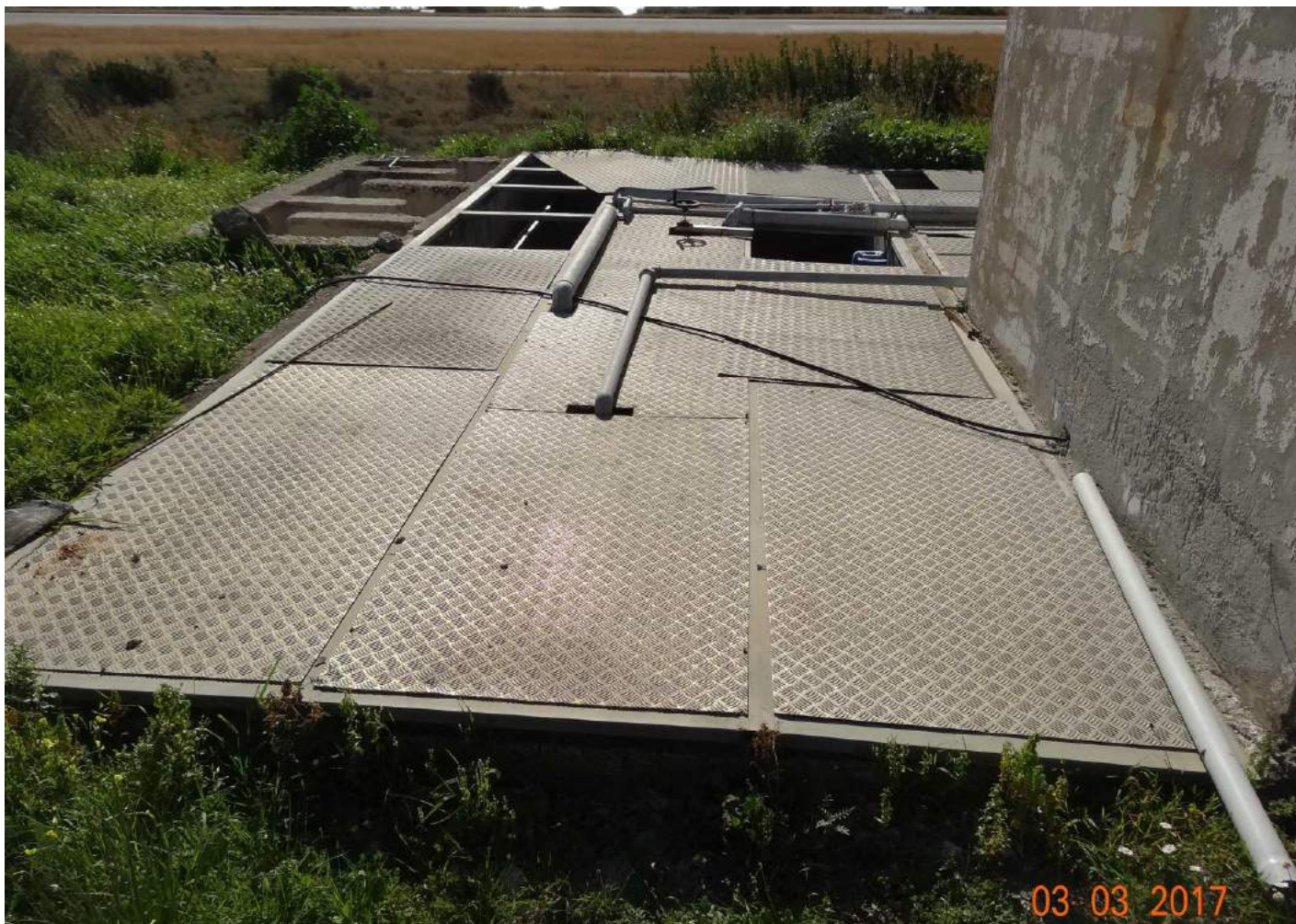
Εικόνα 16: Δεξαμενή λάσπης ΕΕΛ.
