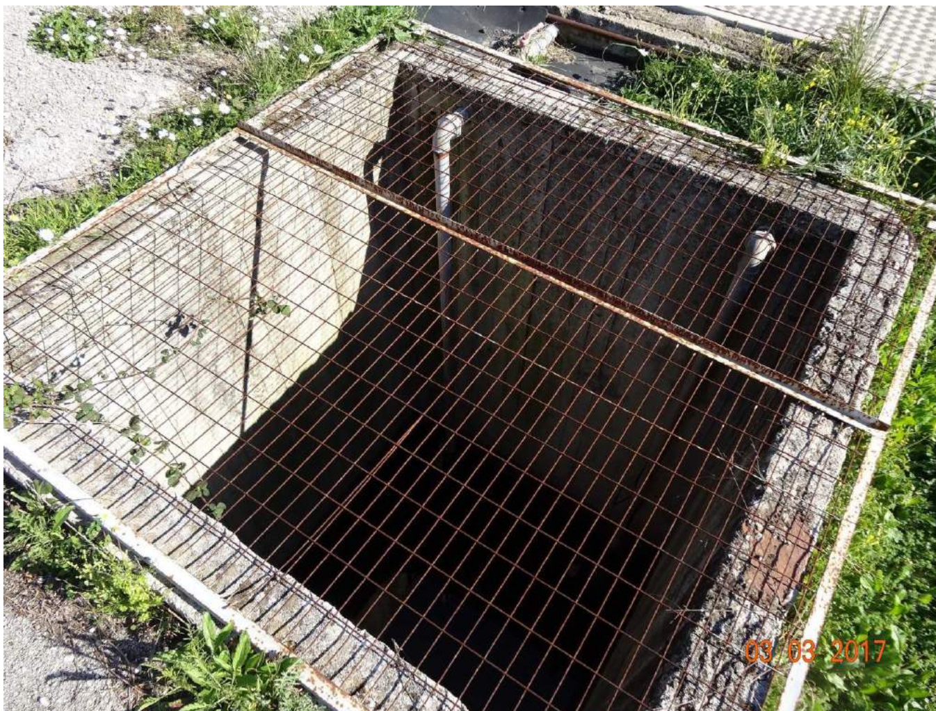
Εικόνα 5: Δεξαμενή ανύψωσης της ΕΕΛ.
