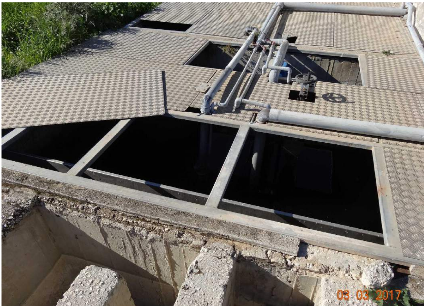
Εικόνα 13: Δεξαμενή καθίζησης ΕΕΛ.
