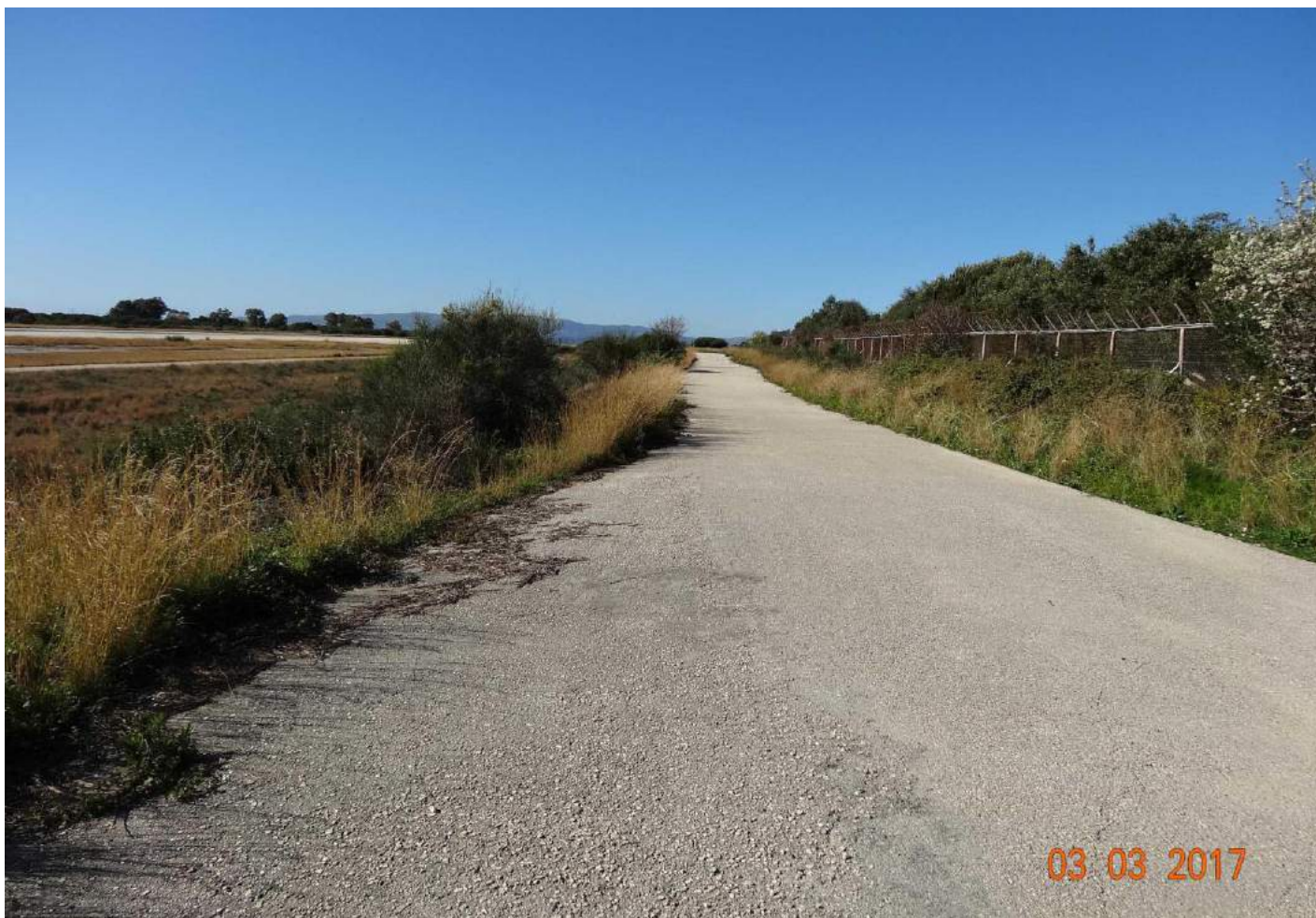
Εικόνα 4: Οδός πρόσβασης στην ΕΕΛ του αερολιμένα Κεφαλληνίας. Στα αριστερά διακρίνεται τμήμα του διαδρόμου προσγειώσεων – απογειώσεων και στα δεξιά, τμήμα της περίφραξης του αεροδρομίου.
