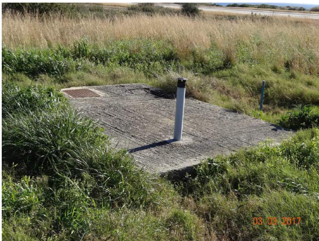
Εικόνα 2.1: Στεγανός βόθρος προσωρινής αποθήκευσης λυμάτων αστικού τύπου των αεροσκαφών.
