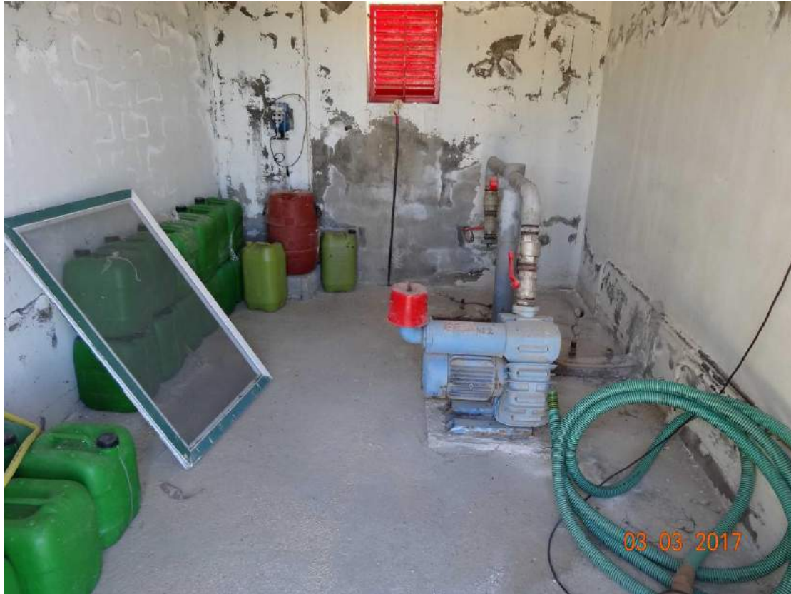
Εικόνα 8: Άποψη του εσωτερικού του οικίσκου της ΕΕΛ. Στο δάπεδο του οικίσκου, διακρίνεται ο φυσητήρας για την παροχή αέρα, στην δεξαμενή παρατεταμένου αερισμού.
