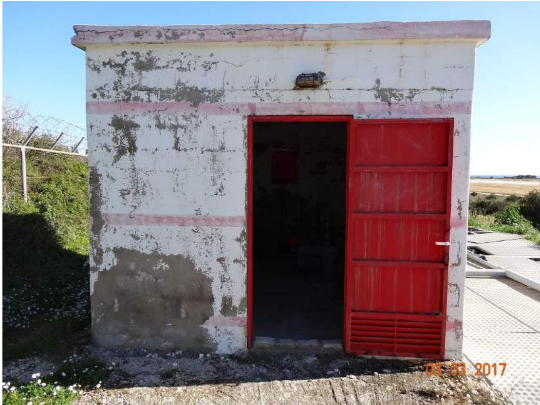
Εικόνα 7: Άποψη της εισόδου του οικίσκου της ΕΕΛ.
