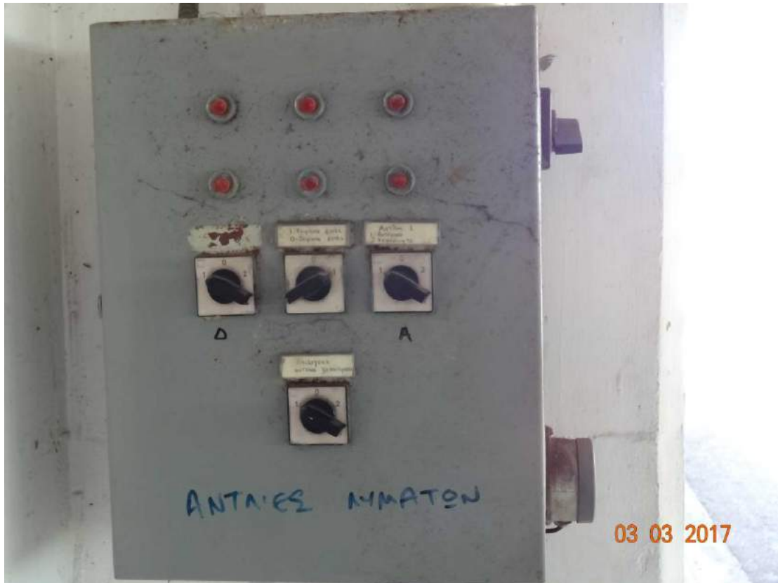
Εικόνα 2: Πίνακας ελέγχου λειτουργίας αντλιών, κεντρικού αντλιοστασίου λυμάτων του αεροσταθμού.
