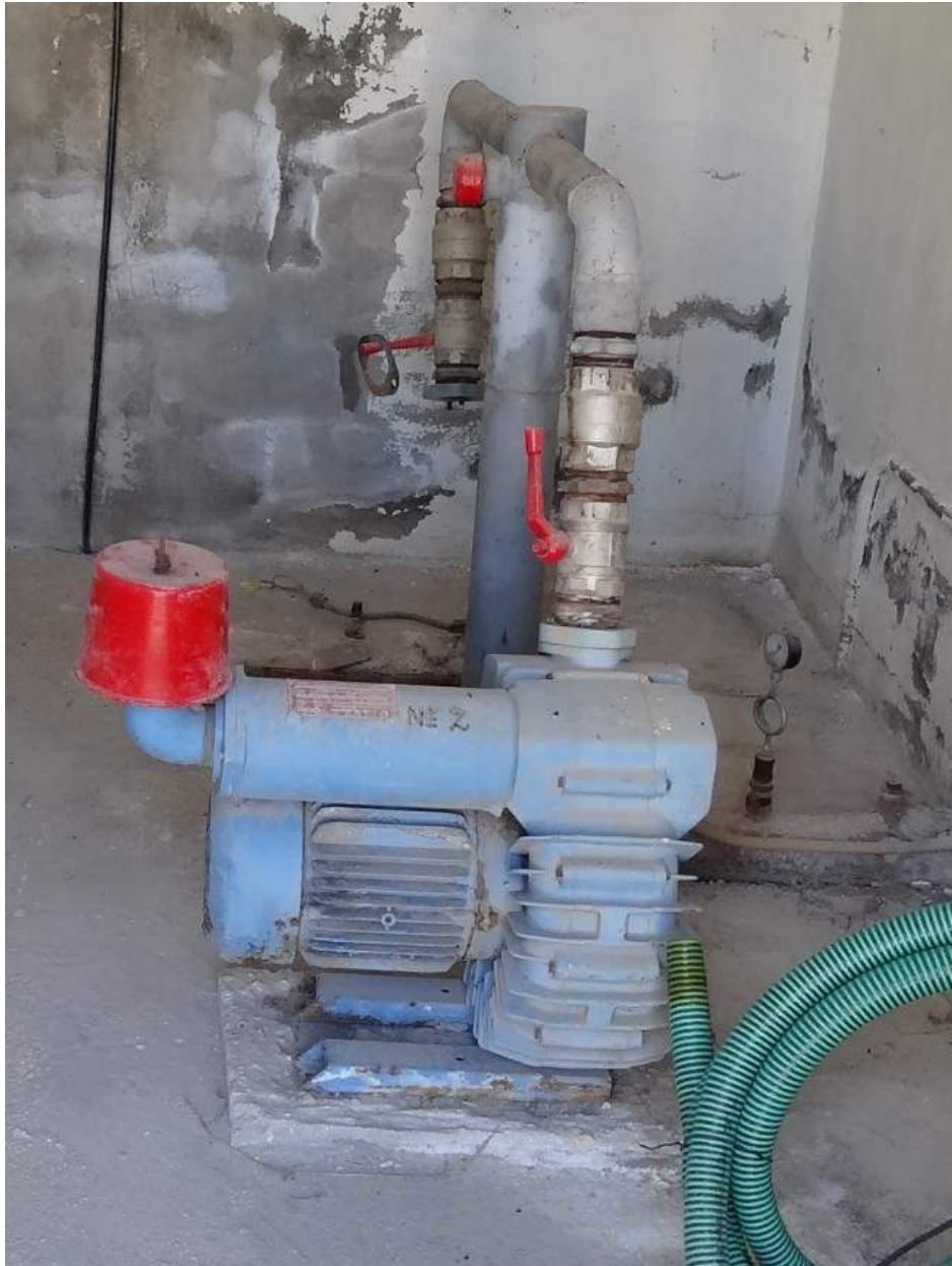
Εικόνα 9: Φυσητήρας για την παροχή αέρα, στην δεξαμενή παρατεταμένου αερισμού της ΕΕΛ.
