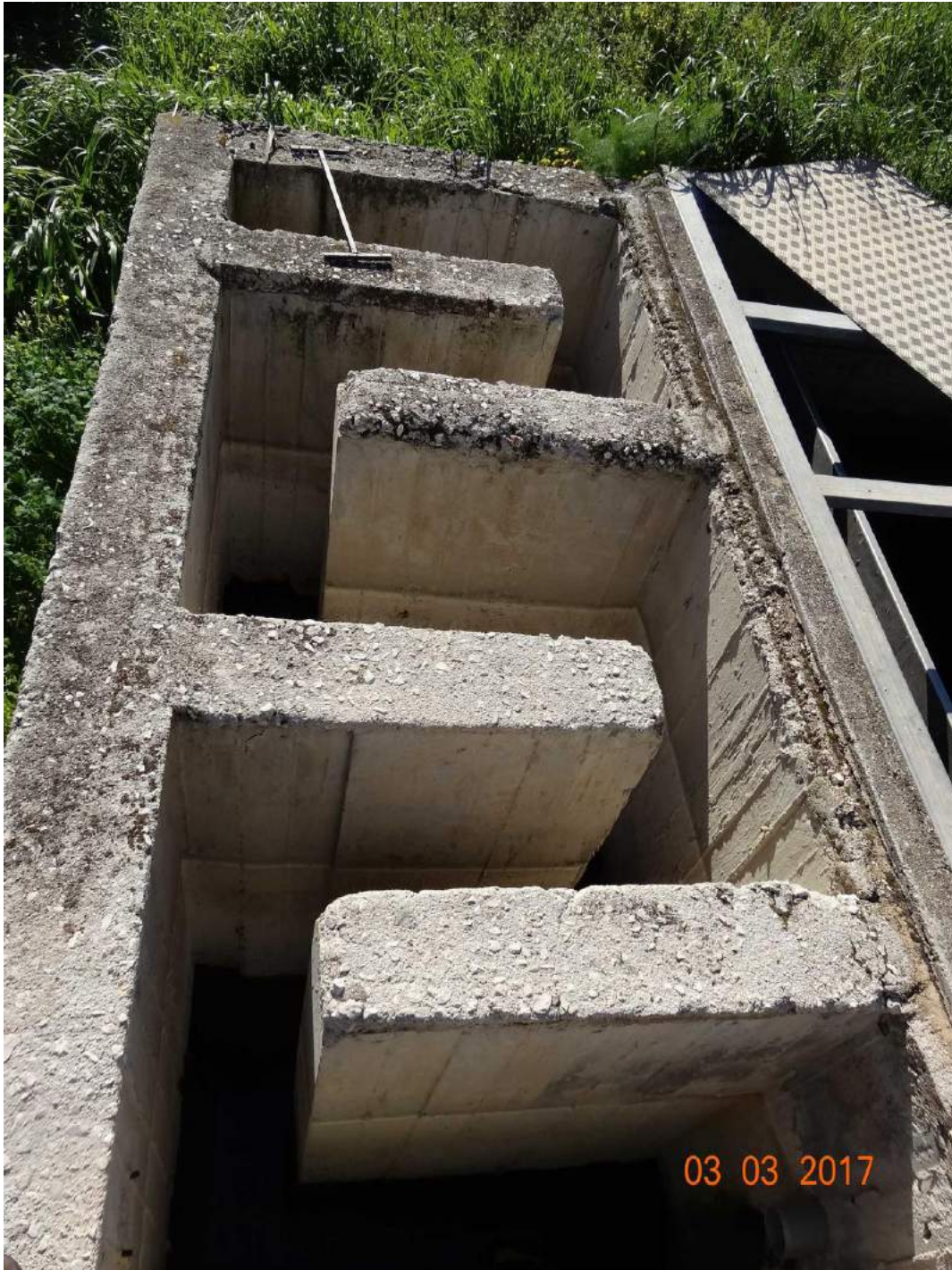
Εικόνα 14: Μαιανδρική δεξαμενή χλωρίωσης ΕΕΛ.
