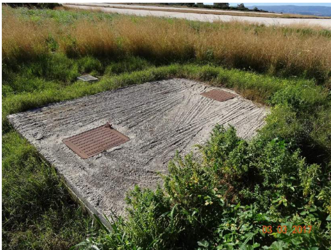
Εικόνα 2.2: Στεγανός βόθρος προσωρινής αποθήκευσης λυμάτων αστικού τύπου των αεροσκαφών.
