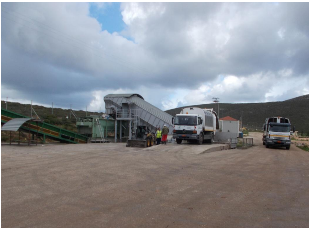
Εικόνα 12: Χώρος υποδοχής απορριματοφόρων στη μονάδα μηχανικής επεξεργασίας
