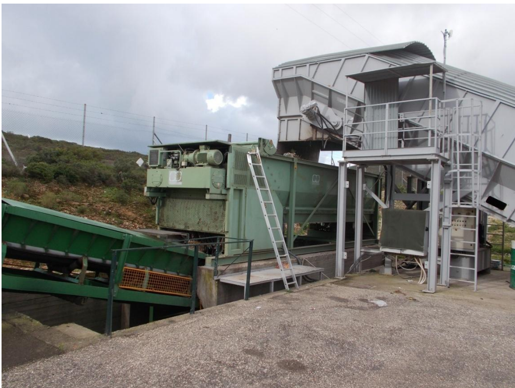
Εικόνα 10: Αποψη μονάδας μηχανικής επεξεργασίας
