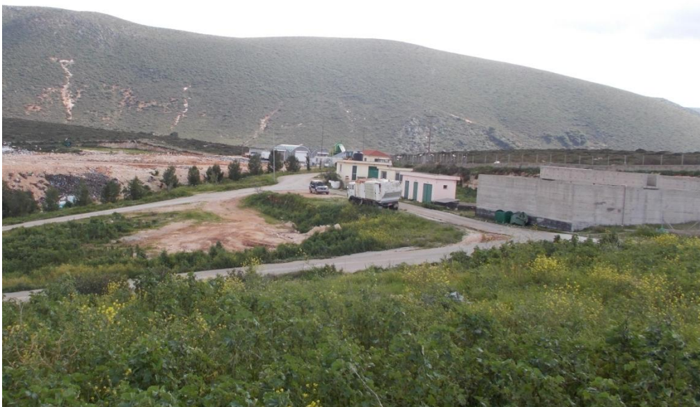
Εικόνα 4: Άποψη λεκάνης και έργων υποδομής
