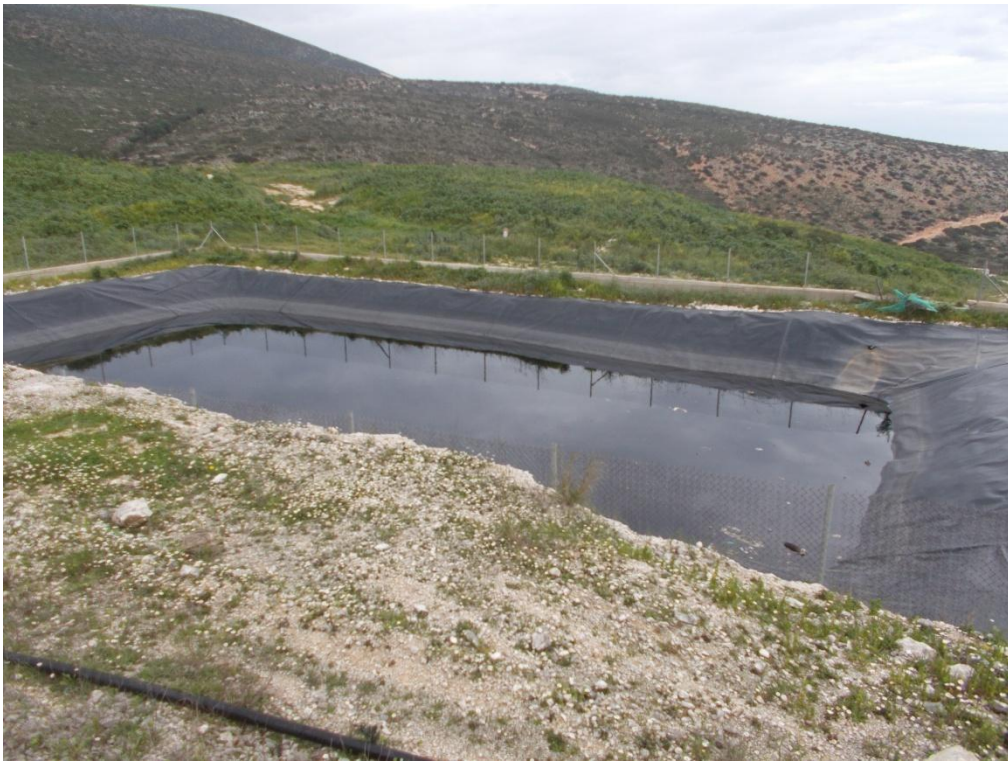
Εικόνα 7: Δεξαμενή εξισορρόπησης στραγγισμάτων
