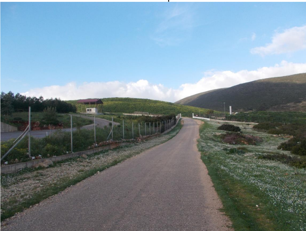
Εικόνα 2: Περίφραξη εγκατάστασης και δρόμος πρόσβασης
