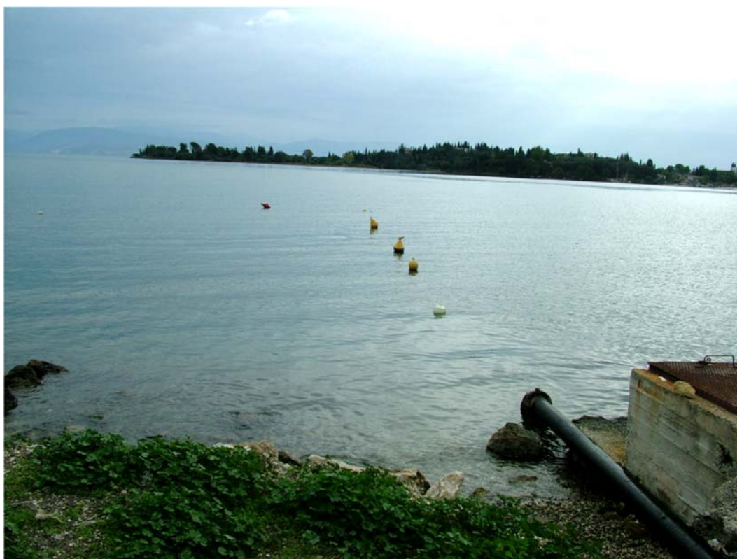
Τέλος χερσαίου τμήματος αγωγού, αρχή και τέλος υποθαλάσσιου
