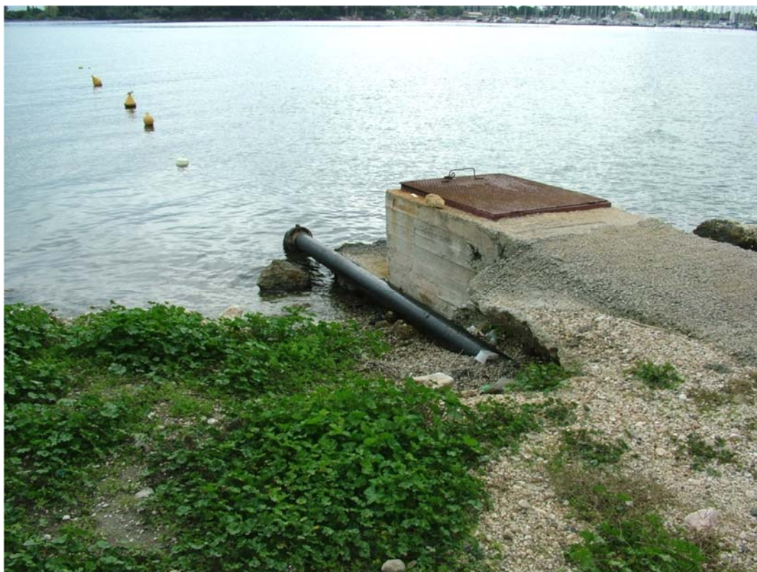
Τέλος χερσαίου τμήματος αγωγού, αρχή και τέλος υποθαλάσσιου
