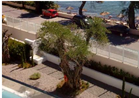
Φώτο 6.10: Νέος διαμορφωμένος χώρος έμπροσθεν κτηρίου ΝΑΥΣΙΚΑ
