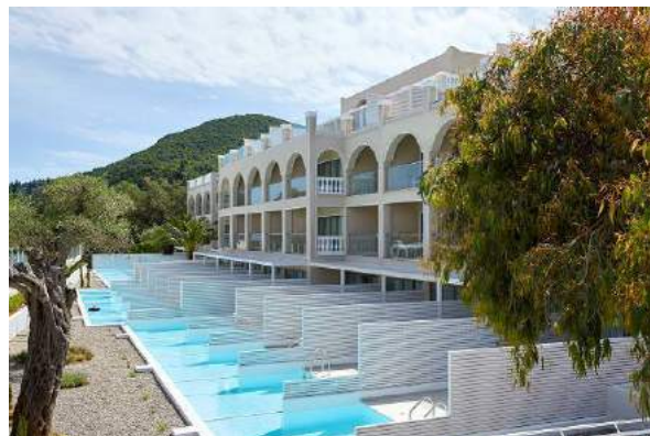
Φώτο 10-3: Άποψη των νέων περιβαλλοντικά αδειοδοτημένων κολυμβητικών δεξαμενών στο κτήριο ΝΑΥΣΙΚΑ βάσει υπ. Αριθμ. 17055/31-03-2016 Απόφασης Γ.Δ.Π.Π.ΥΠΕΝ «Τροποποίηση υπ. Αριθμ. 190900/3871/24-10-2008 ΑΕΠΟ του ξενοδοχείου»
