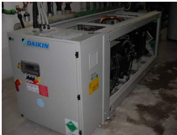
Φώτο 2.1-3: Αντλία θερμότητας DAIKIN ονομαστικής θερμαντικής ικανότητας 142 KW
