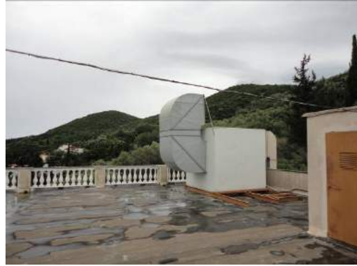
Φώτο 6.4: Ηχομονωτικός κλωβός συστήματος εξαερισμού κουζίνας
