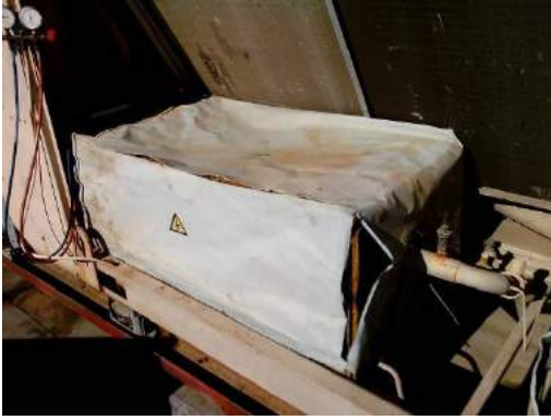
Φώτο 6.3: Θορυβώδεις μηχανήματα πύργου ψύξης σε ηχομονωτικό κλωβό
