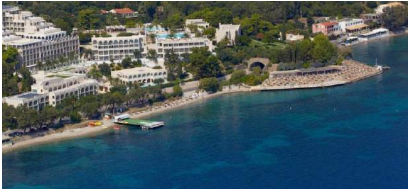
Φώτο 10-5 Παράκτια περιοχή μελέτης υφιστάμενου ξενοδοχειακού συγκροτήματος. Στα αριστερά της φωτογραφίας παρατηρούμε την υφιστάμενη ξύλινη εξέδρα επί πασάλων, για την οποία έχει αδειοδοτηθεί περιβαλλοντικά η μετασκευή της σε σχήμα «Γ». Αριστερά της εξέδρας ξεκινάει ο υφιστάμενος υποθαλάσσιος αγωγός.
