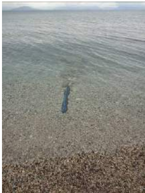
Φώτο 10-8 Υφιστάμενος υποθαλάσσιος αγωγός διάθεσης επεξεργασμένων λυμάτων ξενοδοχειακού συγκροτήματος
