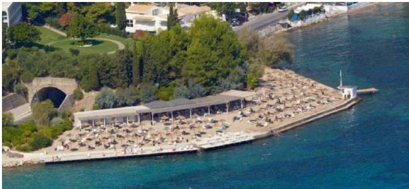
Φώτο 10-6 Σε πρώτη άποψη τα αδειοδοτημένα περιβαλλοντικά έργα διαμόρφωσης ακτής στην παραλία έμπροσθεν του ξενοδοχείου. Στα δεξιά της φωτογραφίας διακρίνεται η υφιστάμενη μικρή ξύλινη εξέδρα επί πασάλων για την οποία έχει αδειοδοτηθεί περιβαλλοντικά η διατήρησή της.
