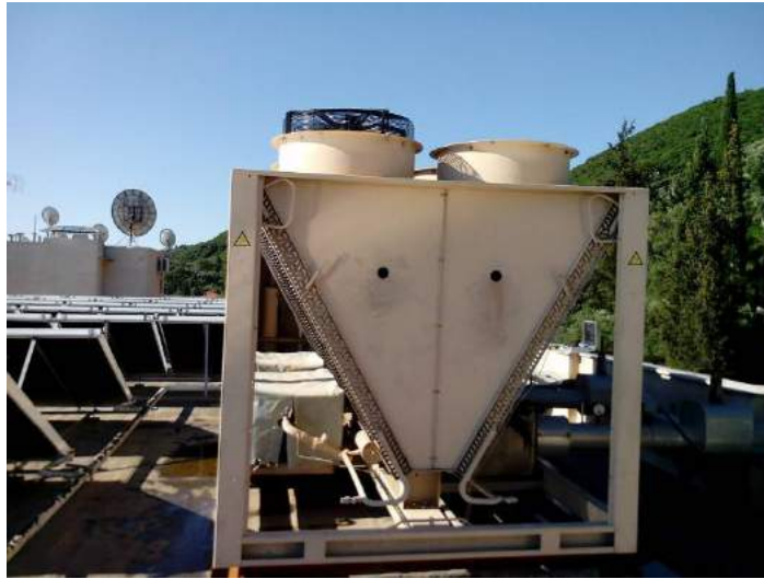
Πίνακας 6-12: Ηλιακοί συλλέκτες στην οροφή του κεντρικού κτηρίου του ξενοδοχείου, δίπλα από τον πύργο ψύξης
