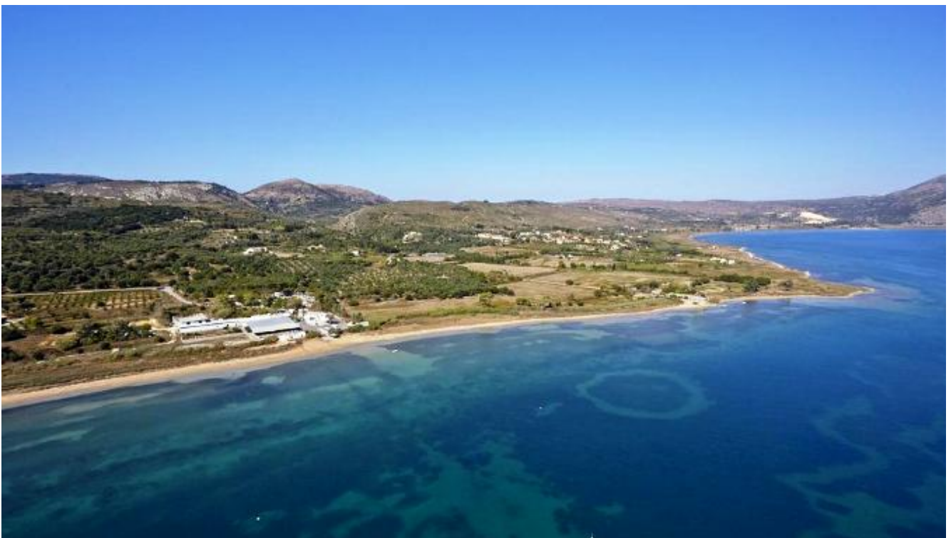
Ευρύτερη περιοχή ανάντη των εγκαταστάσεων
