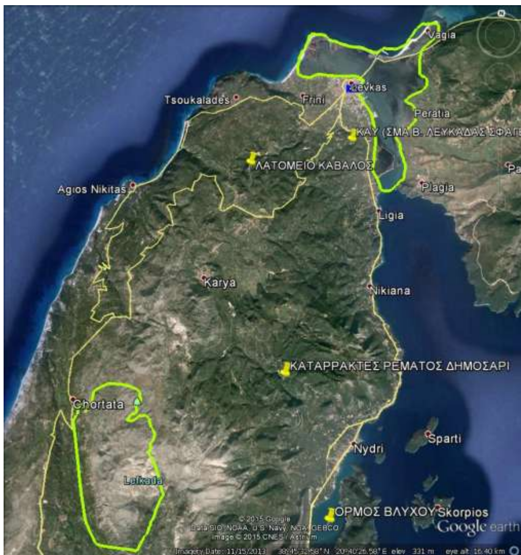
Φωτό 5.1.1 Θέση έργου (Λατομείο Κάβαλος) και προστατευόμενες περιοχές δικτύου Natura (επισημαίνονται με πράσινο χρώμα): α) Λιμνοθάλασσες Στενών Λευκάδας (Παλιώνης – Αβλίμων) και Αλυκές Λευκάδας, β) Περιοχή Χορτάτων (Λευκάδα)
