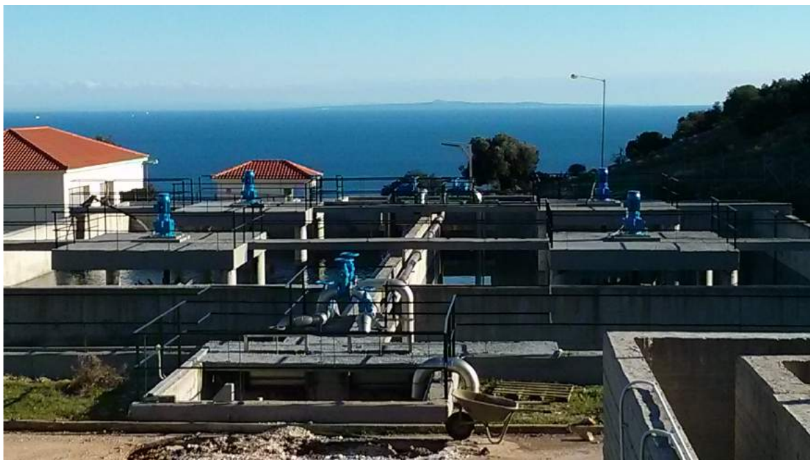
Φωτογραφία 3: Μεριστής και δεξαμενές βιολογικής επεξεργασίας
