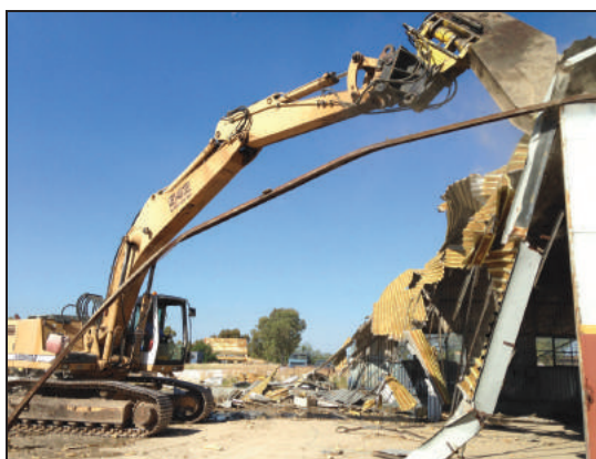
Φωτ. 15 Μηχάνημα έργου με προσαρτημένο ψαλίδι για κοπή βαρέων μεταλλικών αντικειμένων
