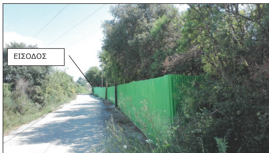
Φωτ. 21 Άποψη του μετώπου από την Β πλευρά του δρόμου
