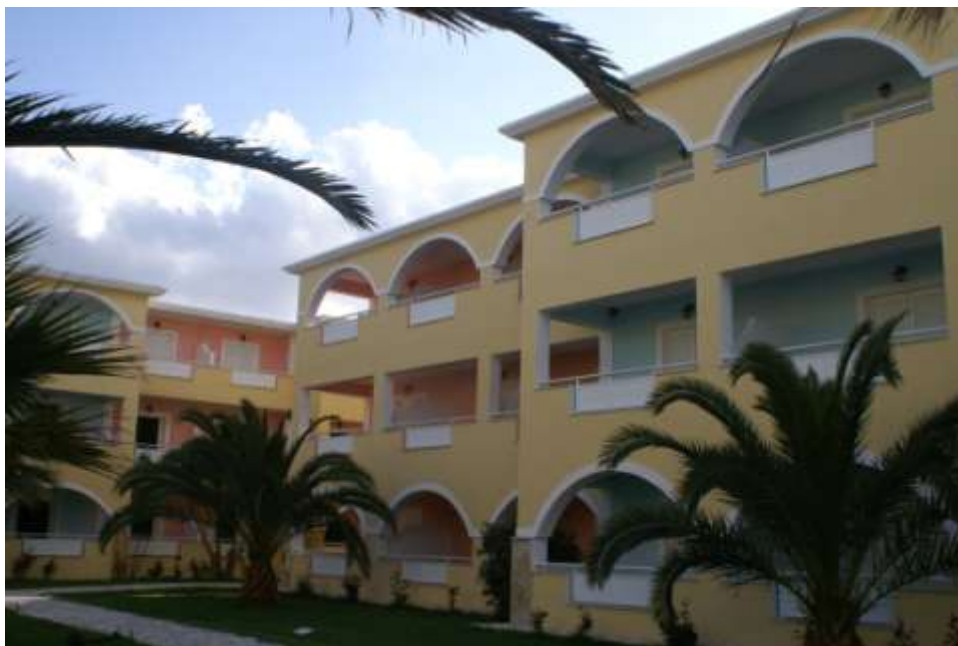
Φωτ. 5. Άποψη του κτηριακών εγκαταστάσεων του ALIKANAS BEACH HOTEL . Ανατολική πλευρά κτηρίου Β (δεξιά) και βόρεια πλευρά κτηρίου Γ
