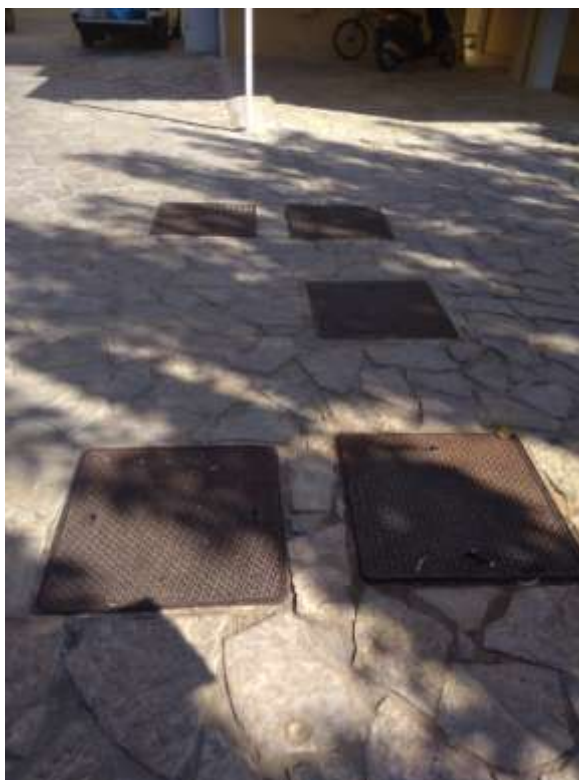
Φωτ. 8. Ο υπόγειος χώρος της μονάδας επεξεργασίας. Διακρίνονται τα καπάκια των φρεατίων και δεξαμενών.
