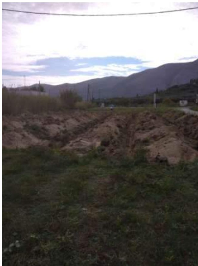
Φωτ. 9. Οι εργασίες βελτίωσης του υπεδάφιου πεδίου διάθεσης.
