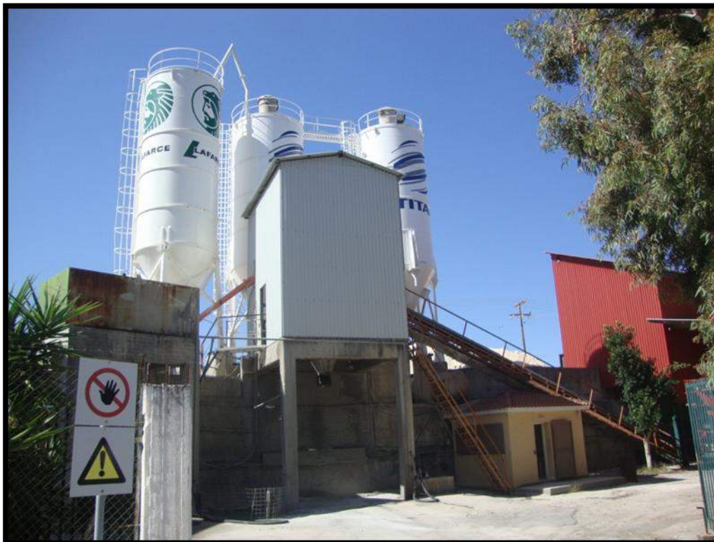
ΕΙΚΟΝΑ 14.4: Άποψη σιλό τσιμέντου, μίξερ σκυροδέματος και χειριστηρίου μίξερ από την ανατολική είσοδο του γηπέδου
