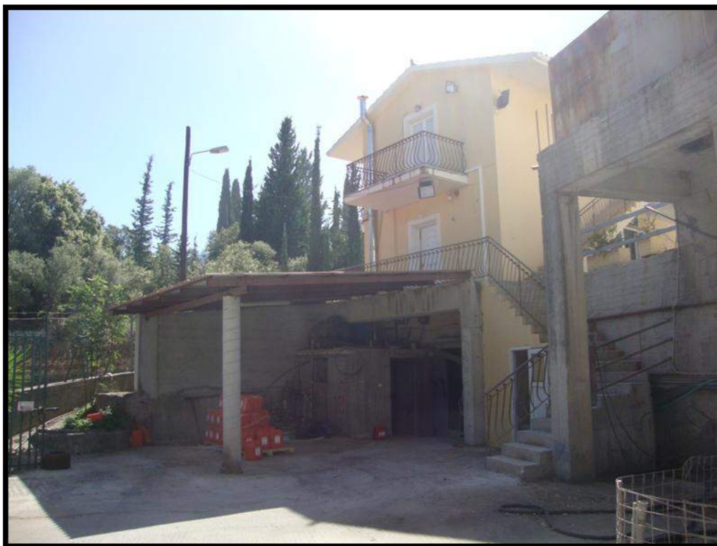
ΕΙΚΟΝΑ 14.5: Στέγαστρο για την αποθήκευση διαφόρων αναλώσιμων
