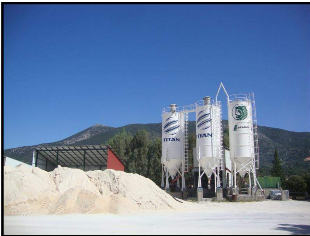
ΕΙΚΟΝΑ 14.2: Σιλό τσιμέντου (δεξιά), Υπαιθρια αποθήκευση και σιλό αδρανών (αριστερά)
