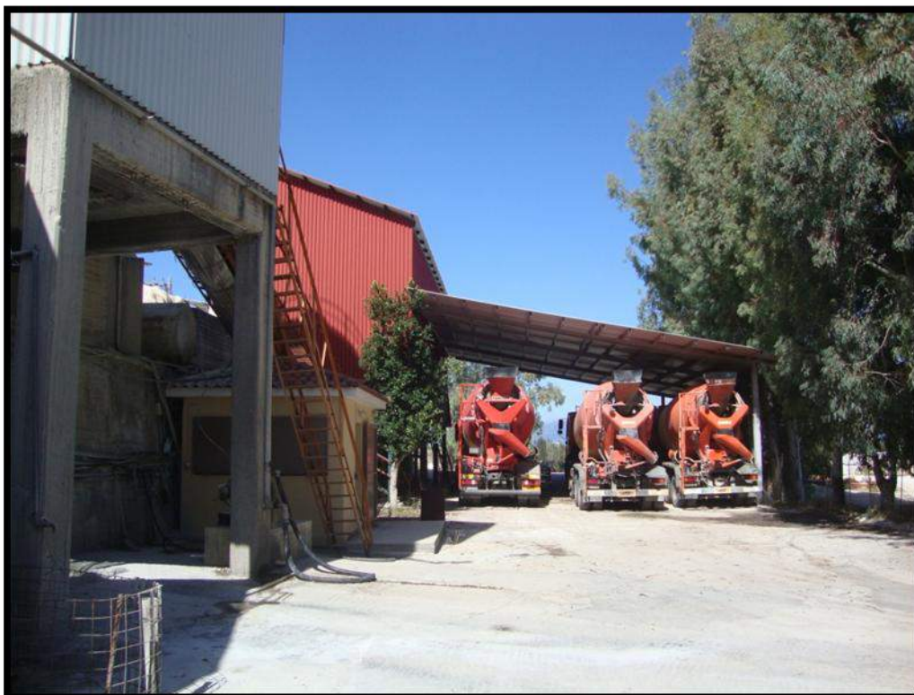
ΕΙΚΟΝΑ 14.3: Στέγαστρο στάθμευσης οχημάτων (δεξιά), χειριστήριο αναμικτήρα σκυροδέματος (αριστερά)
