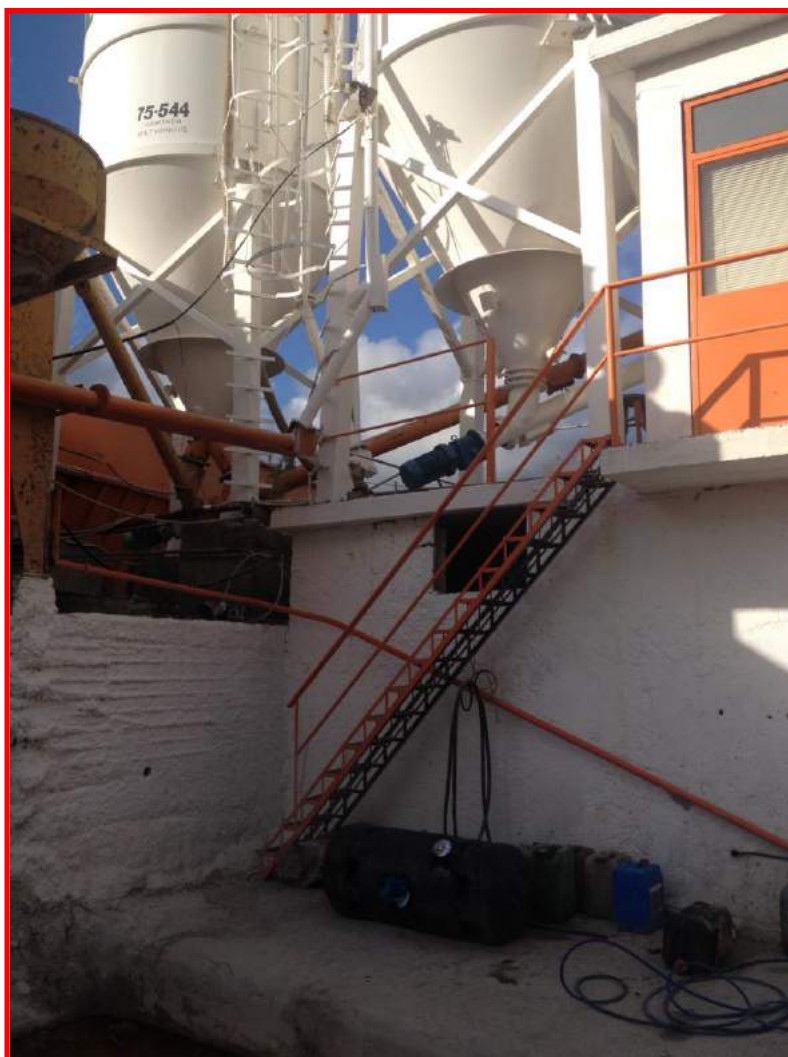
ΕΙΚΟΝΑ 14.5: Άποψη των δύο σιλό τσιμέντου
