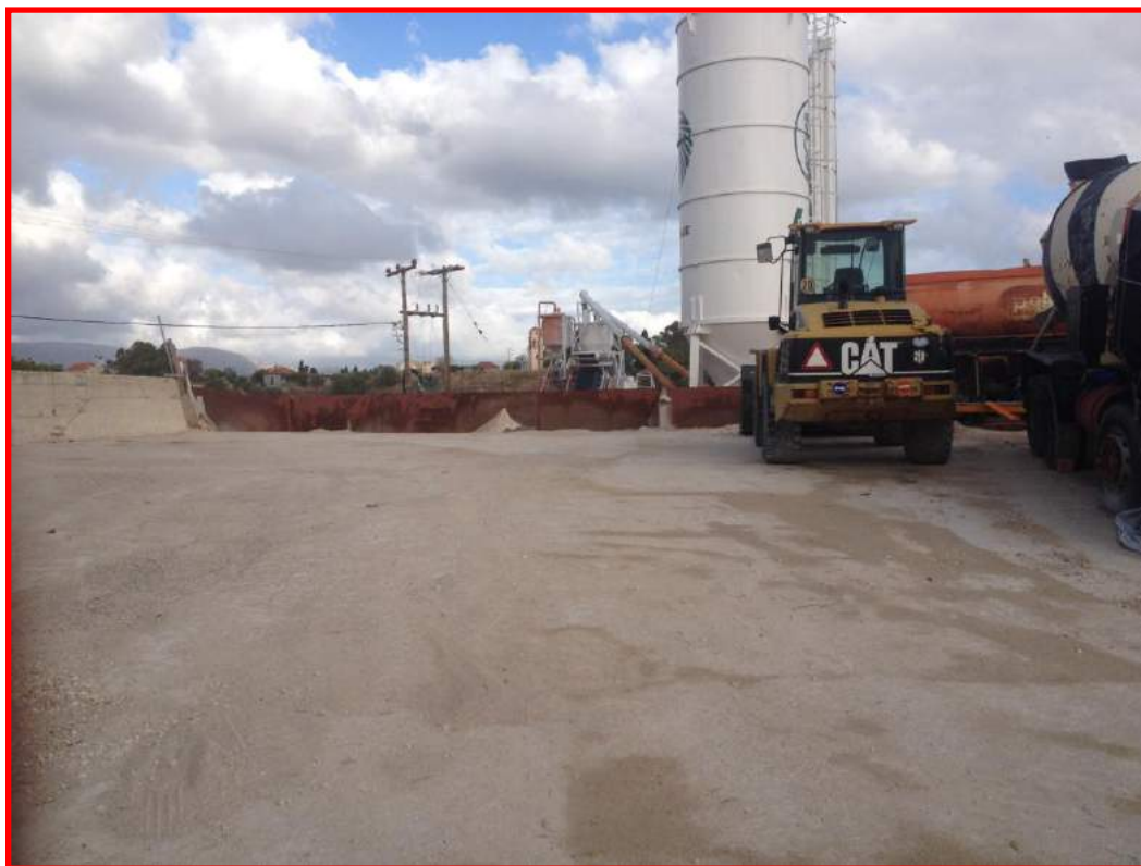
ΕΙΚΟΝΑ 14.4: Άποψη σιλό τσιμέντου και mίxer σκυροδέματος - Γενική άποψη γηπέδου
