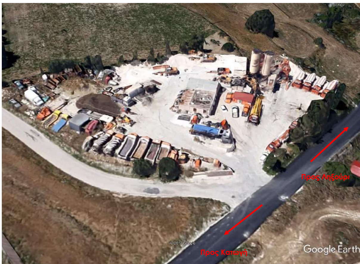
Εικόνα 6.1: Οδική πρόσβαση στο γήπεδο της μονάδας από την Ε.Ο. Ληξουρίου - Κατωγής
