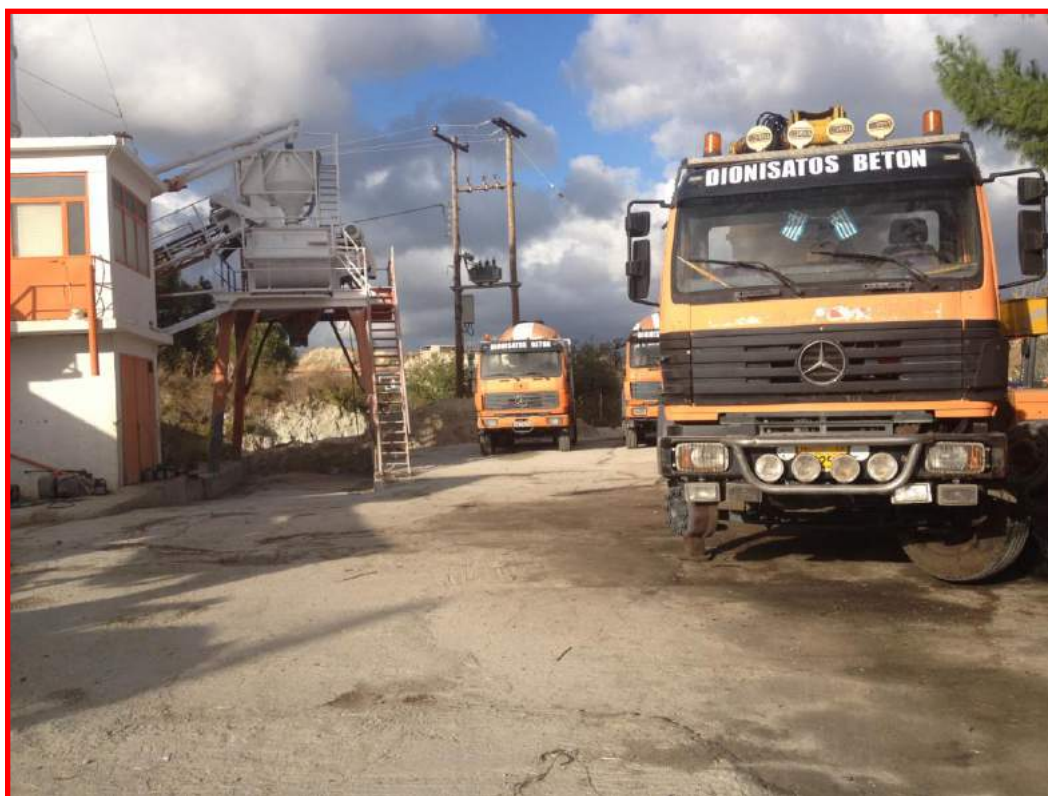
ΕΙΚΟΝΑ 14.1: Άποψη Αναμκτήρα Σκυροδέματος
