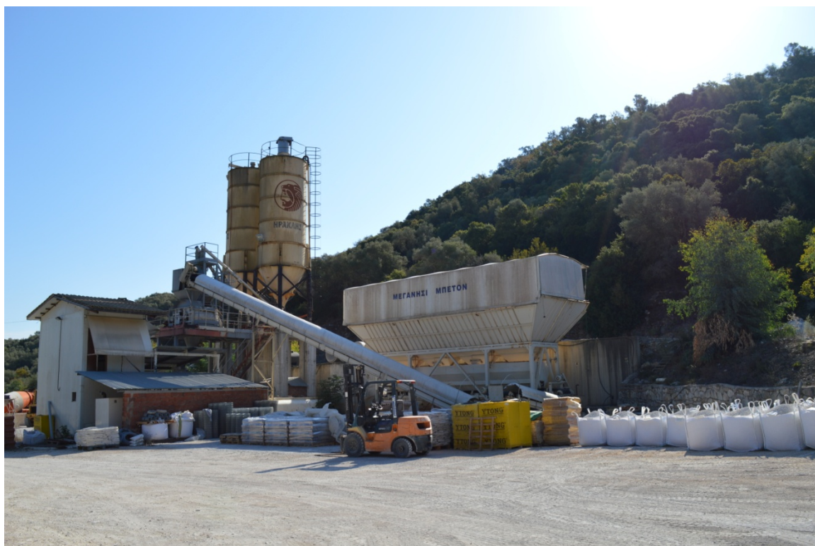
Φ2: Άποψη μηχανολογικών εγκαταστάσεων από τα Δκά.
