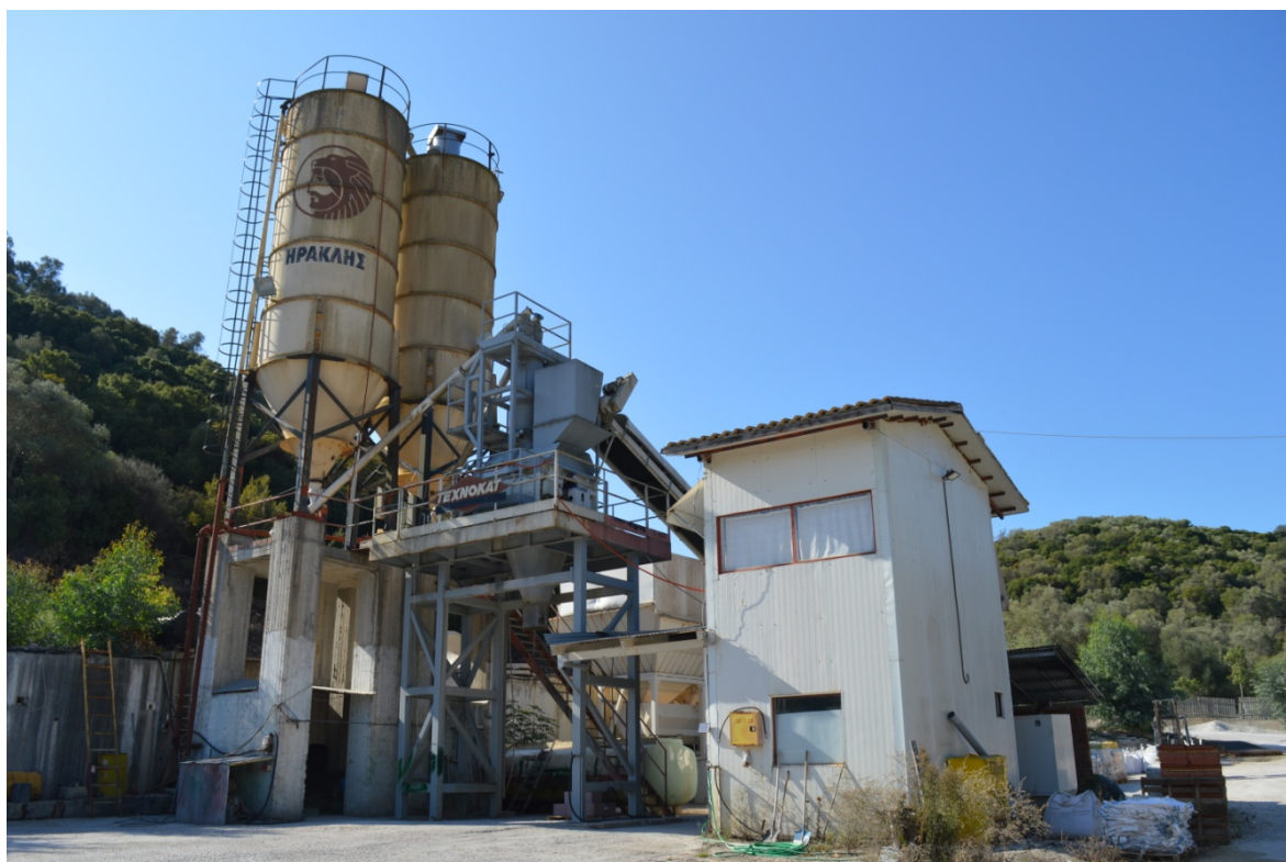
Φ4: Άποψη μηχανολογικών εγκαταστάσεων από τα ΒΑκά.
