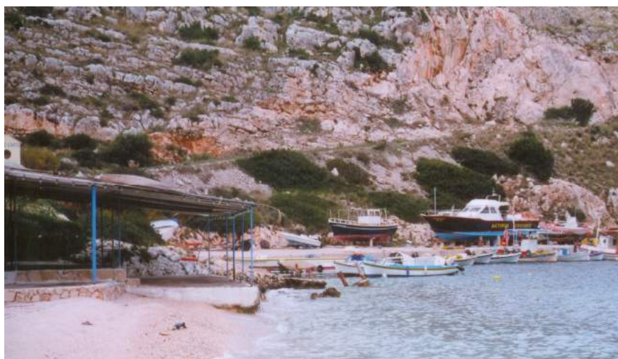
ΦΩΤΟ Φ9: Παλιά αυτοσχέδια λιμενικά έργα στη Δ ακτογραμμή του όρμου Αγ. Νικολάου, σε συνέχεια με το υφιστάμενο αλιευτικό καταφύγιο
