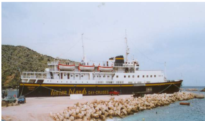
ΦΩΤΟ Φ6: Εξωτερική θωράκιση Υ1-Υ2 Κρηπιδότοιχου και Κρηπιδό- τοιχος Ε/Γ-Ο/Γ Υ4-Υ5
