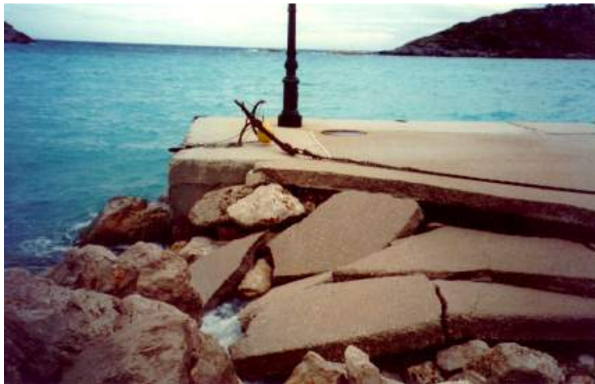
ΦΩΤΟ Φ5: Εξωτερική θωράκιση Υ1-Υ2 Κρηπιδότοιχου και Κρηπιδό- τοιχος Ε/Γ-Ο/Γ Υ4-Υ5
