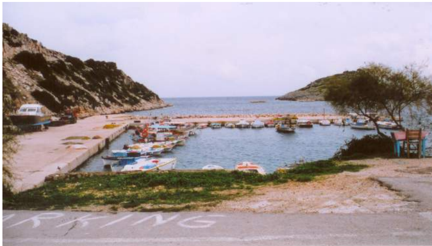
ΦΩΤΟ Φ10: Υφιστάμενο αλιευτικό καταφύγιο Υ15-...-Υ20
