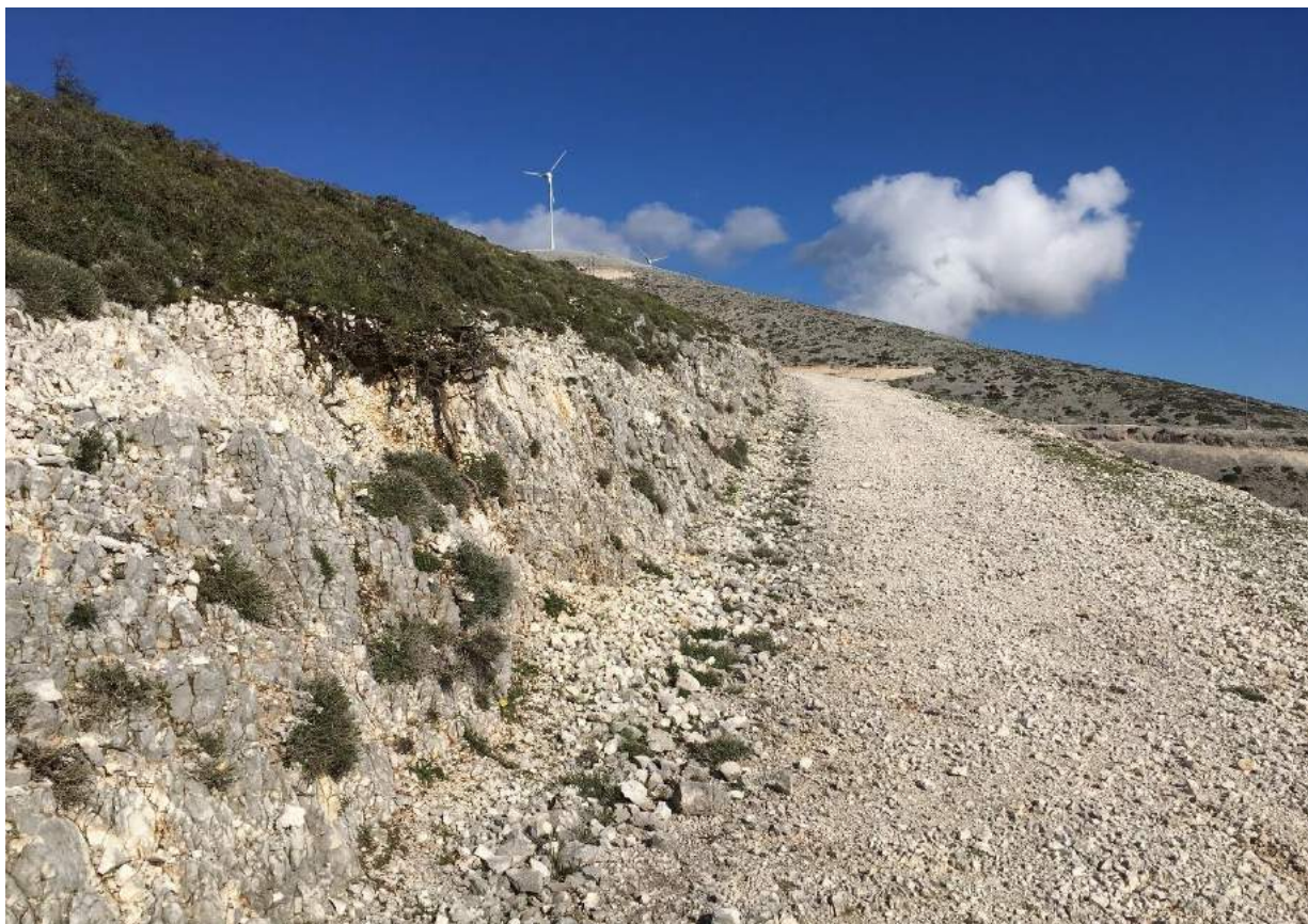
Εικόνα 16. Αγροτική οδός προς το γήπεδο εγκατάστασης του ΑΠ στη θέση «Ξερακιά» Π.Ε. Κεφαλληνίας.
