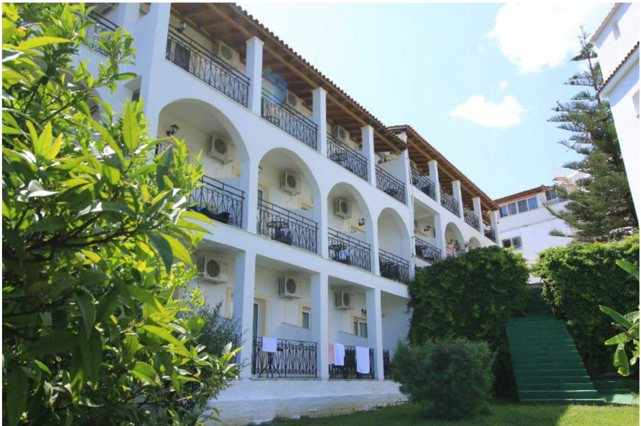
Εικόνα 6: Άποψη Κτιρίου Β.
