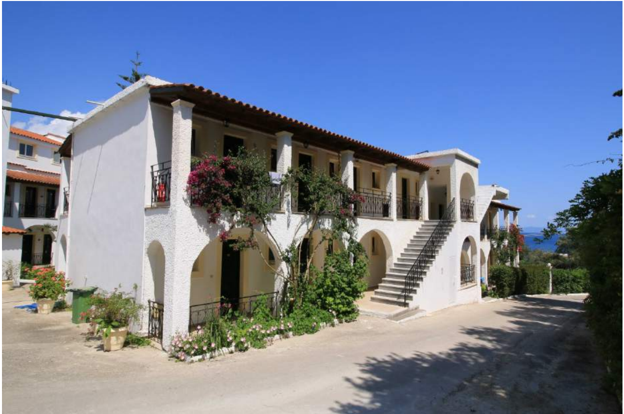
Εικόνα 5: Άποψη Κτιρίου Β.
