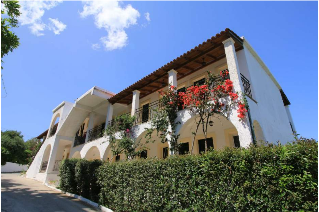
Εικόνα 3: Άποψη Κτιρίου Β.
