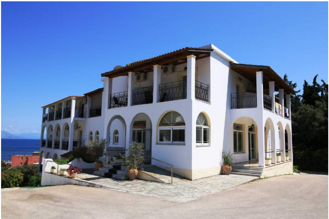
Εικόνα 4: Άποψη Κτιρίου Α.
