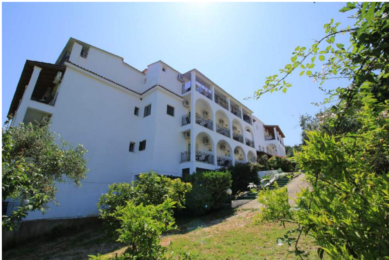
Εικόνα 7: Άποψη Κτιρίου Α.
