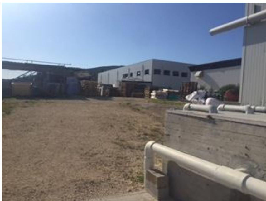
Χώρος νέου RAS
