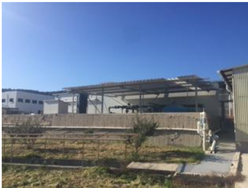
Χώρος νέου κτιρίου για την επεξεργασία του νερού των γεωτρήσεων
