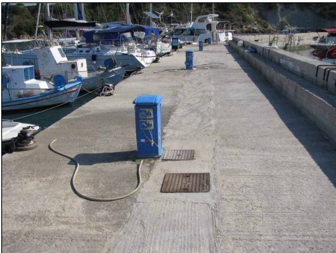
Φωτογραφία 6: Πίλαρ νερού και ρεύματος στον υπήνεμο μόλο. Προσανατολισμός ΝΔ → ΒΑ
