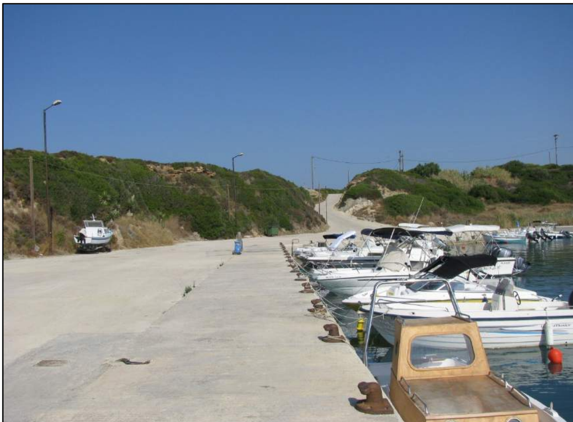
Φωτογραφία 3: Εσωτερικό κρηπίδωμα μήκους 52m. Προσανατολισμός ΝΑ→ΒΔ
