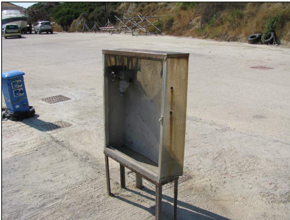
Φωτογραφία 5: Πίλαρ δικτύου πυρόσβεσης, Προσανατολισμός Β → Ν
