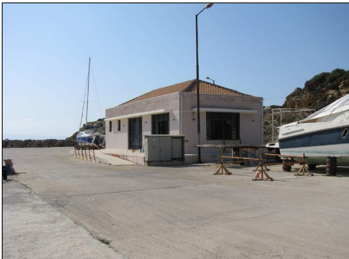
Φωτογραφία 4: Κτήριο Γραφείου, Χώρων Υγιεινής και Αποθήκης. Προσανατολισμός Β → Ν
