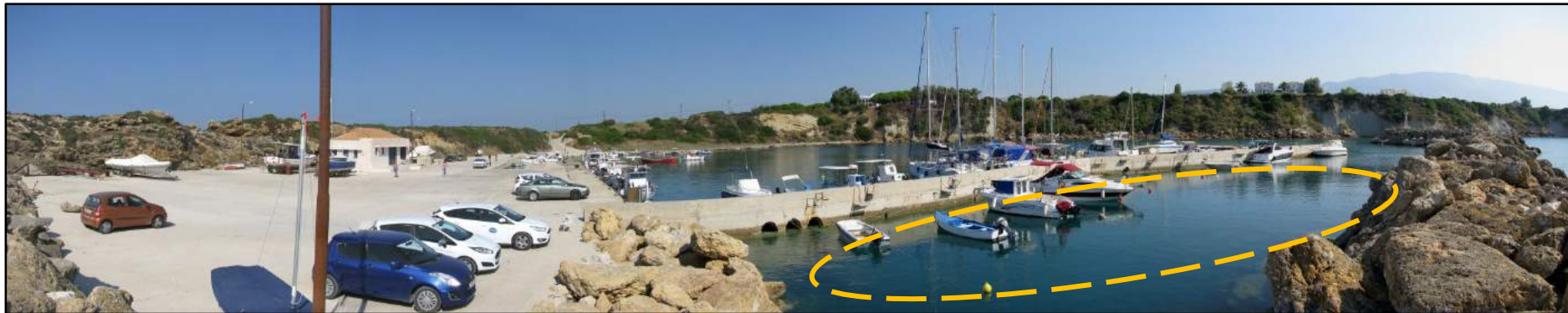
Φωτογραφία 8: Διάκενο αποτόνωσης του κυματισμού. Προσανατολισμός Ν → Β
