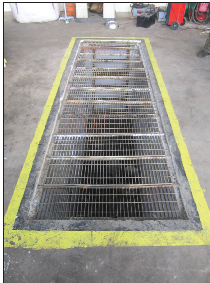
Φωτ. 3 Ο λάκκος βαρέων οχημάτων εντός του βιομηχανοστασίου
