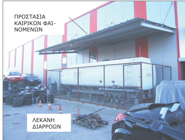
Φωτ. 36 Βυτίο υγρών ΕΑ σε διαλυτήριο ΟΤΚΖ (Αφοί Κατσιαβού ΟΕ - Λαμία)
