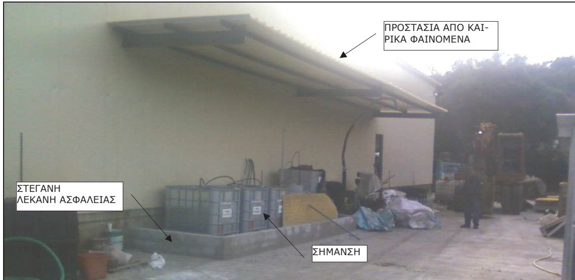
Φωτ. 35 Η υφιστάμενη Λεκάνη Ασφαλείας για την προσωρινή αποθήκευση των υγρών ΕΑ από τα ΟΤΚΖ. Το υπερκείμενο προστέγασμα παρέχει προστασία από τα καιρικά φαινόμενα
