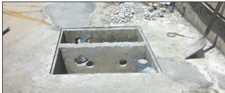
Φωτ. 37 Ο ελαιοδιαχωριστής νερών πλύσης βιομηχανοστασίου κατά την κατασκευή και σήμερα με εμφανή τα δεσμευμένα ελαιώδη
