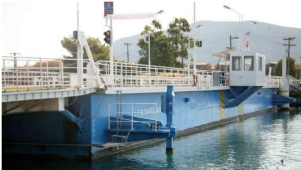
Εικόνα 6.2: Υφιστάμενη πλωτή γέφυρα Λευκάδας
