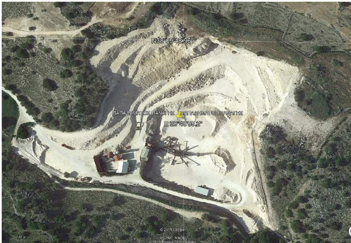
αεροφωτογραφία λατομικού χώρου
