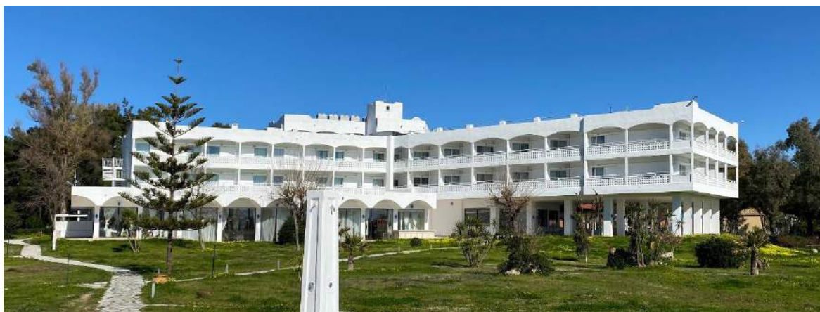
Φωτο 6.2.1 Γενική άποψη του κεντρικού κτιριακού όγκου (ΝΔ όψη)
