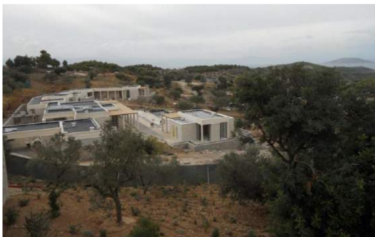
Φωτο. 9.3.5 Εργασίες κατασκευής τουριστικών επιπλωμένων κατοικιών του Ξενοδοχειακού συγκροτήματος Amanzoe κατηγορίας 5 αστέρων στον Αγ. Παντελεήμονα Δήμου Ερμιονίδας.
