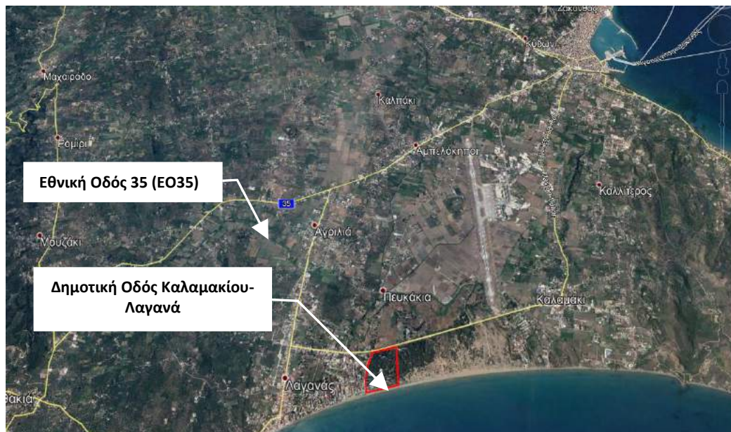
Σχήμα 8.8-1 Δορυφορική άποψη κύριου υφιστάμενου οδικού δικτύου περιοχής μελέτης (Υπόβαθρο: GoogleEarth, 2014). Με κόκκινο σημειώνεται το γήπεδο του έργου
