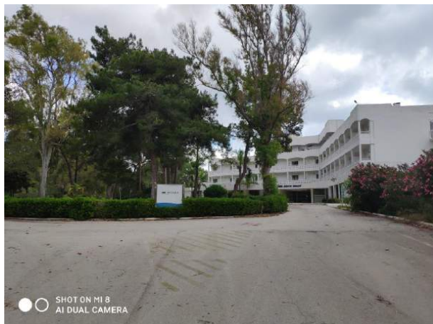
Φωτο. 9.5.2 Άποψη του διαμορφωμένου χώρου στάθμευσης και της υφιστάμενης βλάστησης
