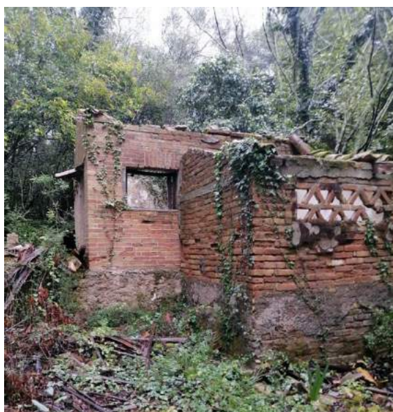
Φωτογραφία 14-8 Άποψη του ερειπωμένου κτιρίου 4 εντός της Ζώνης II του ΕΣΧΑΔΑ
