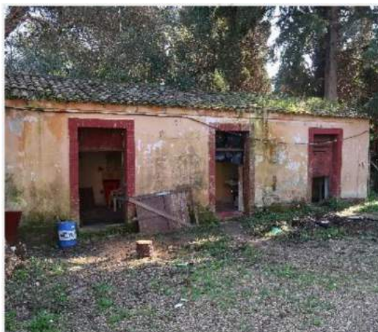
Εικόνα 6.2-11 Άποψη υφιστάμενου Κτιρίου Ζ
