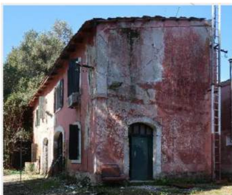
Εικόνα 6.2-8 Άποψη υφιστάμενου Κτιρίου Θ
