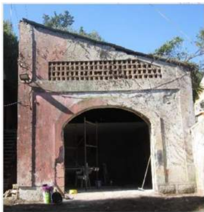
Εικόνα 6.2-9 Άποψη υφιστάμενου Κτιρίου Η
