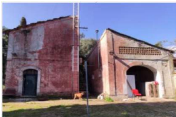
Εικόνα 6.2-10 Άποψη υφιστάμενων Κτιρίων Η & Θ
