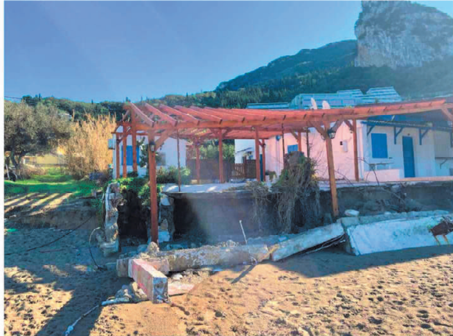
ΛΕΠΤΟΜΕΡΕΙΑ ΤΗΣ ΔΙΑΜΟΡΦΩΜΕΝΗΣ ΚΑΤΑΣΤΑΣΗΣ
