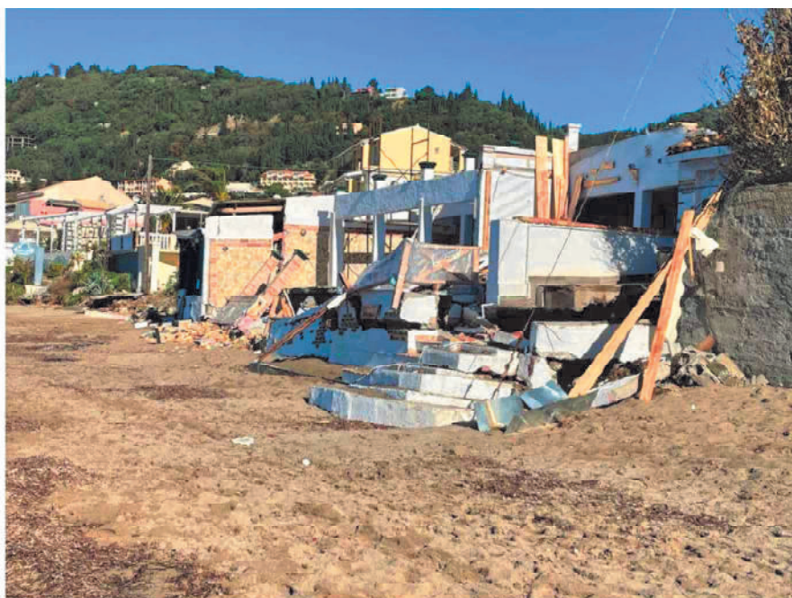
ΛΕΠΤΟΜΕΡΕΙΑ ΤΗΣ ΔΙΑΜΟΡΦΩΜΕΝΗΣ ΚΑΤΑΣΤΑΣΗΣ
