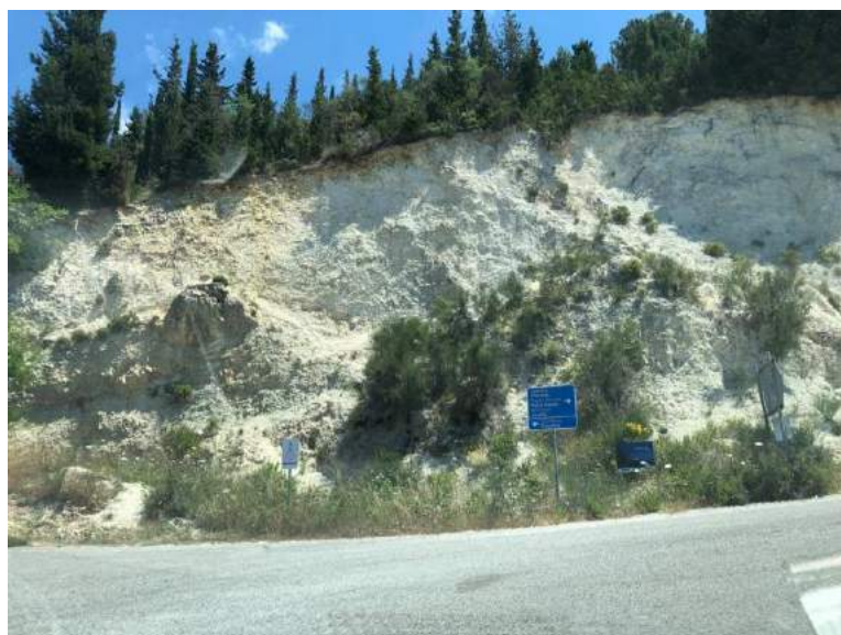
Εικόνα 86: Διασταύρωση με νέο δρόμο προς Χορτάτα
