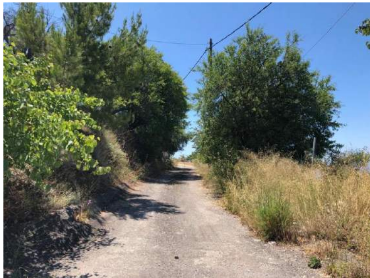
Εικόνα 73: Κατασκευή νέου τμήματος
