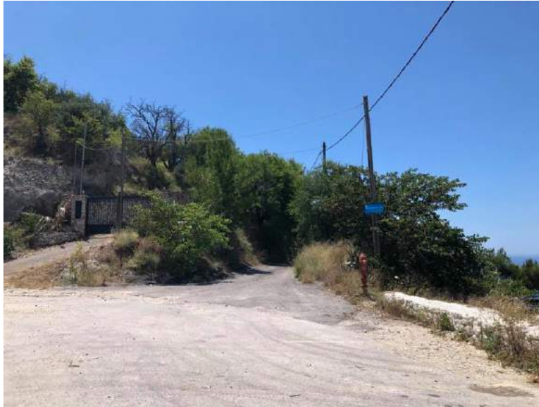
Εικόνα 72: Επαρχιακή Οδός Λευκάδας – Κάτω Εξάνθειας – Θέση Πανόραμα
