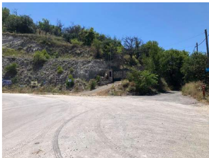
Εικόνα 71: Επαρχιακή Οδός Λευκάδας – Κάτω Εξάνθειας – Θέση Πανόραμα
