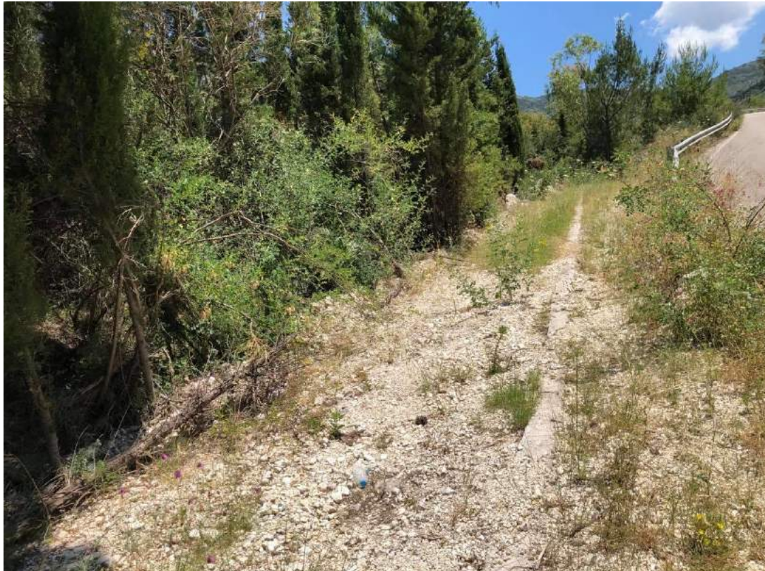
Εικόνα 64: Επαρχιακή Οδός Λευκάδας – Κάτω Εξάνθειας - Περιοχή παράκαμψης
