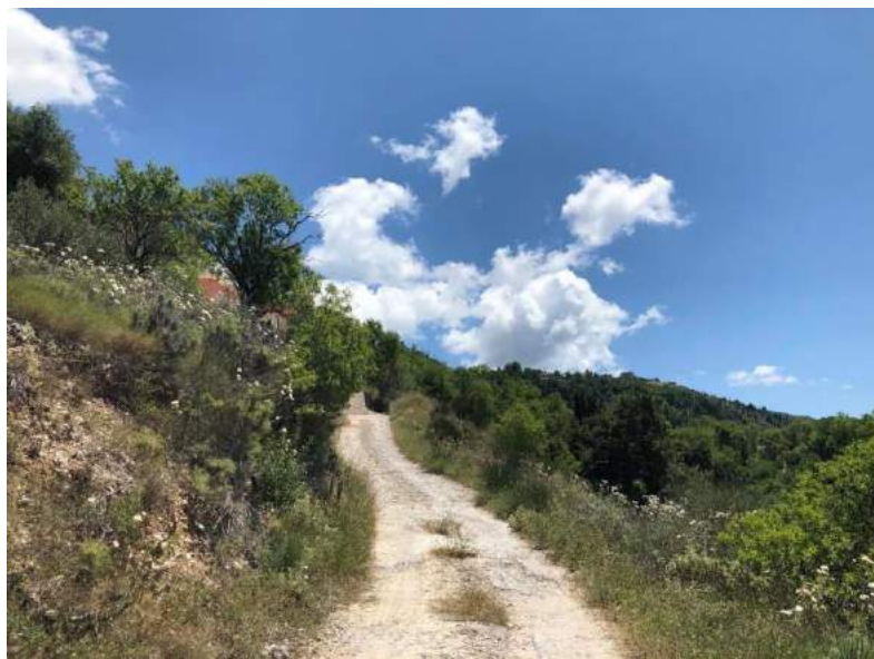
Εικόνα 77: Κατασκευή νέου τμήματος
