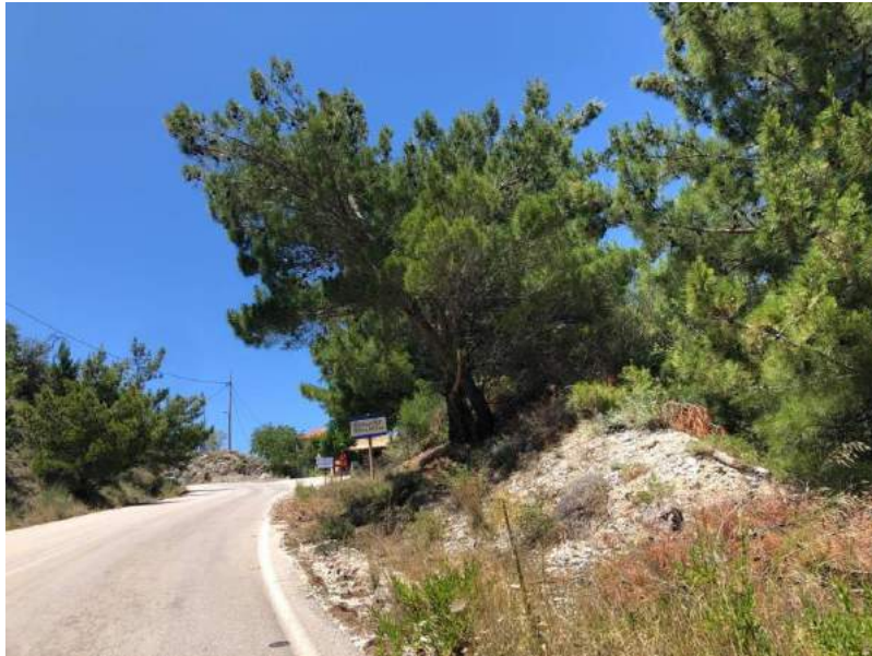
Εικόνα 69: Επαρχιακή Οδός Λευκάδας – Κάτω Εξάνθειας – Είσοδος Καλαμιτσίου
