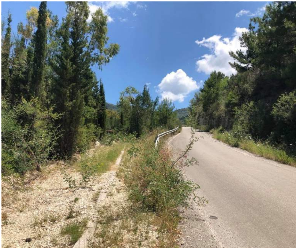
Εικόνα 63: Επαρχιακή Οδός Λευκάδας – Κάτω Εξάνθειας - Περιοχή παράκαμψης
