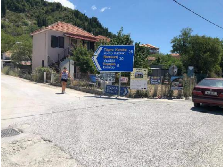
Εικόνα 78: Κατασκευή νέου τμήματος
