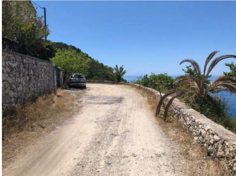
Εικόνα 75: Κατασκευή νέου τμήματος
