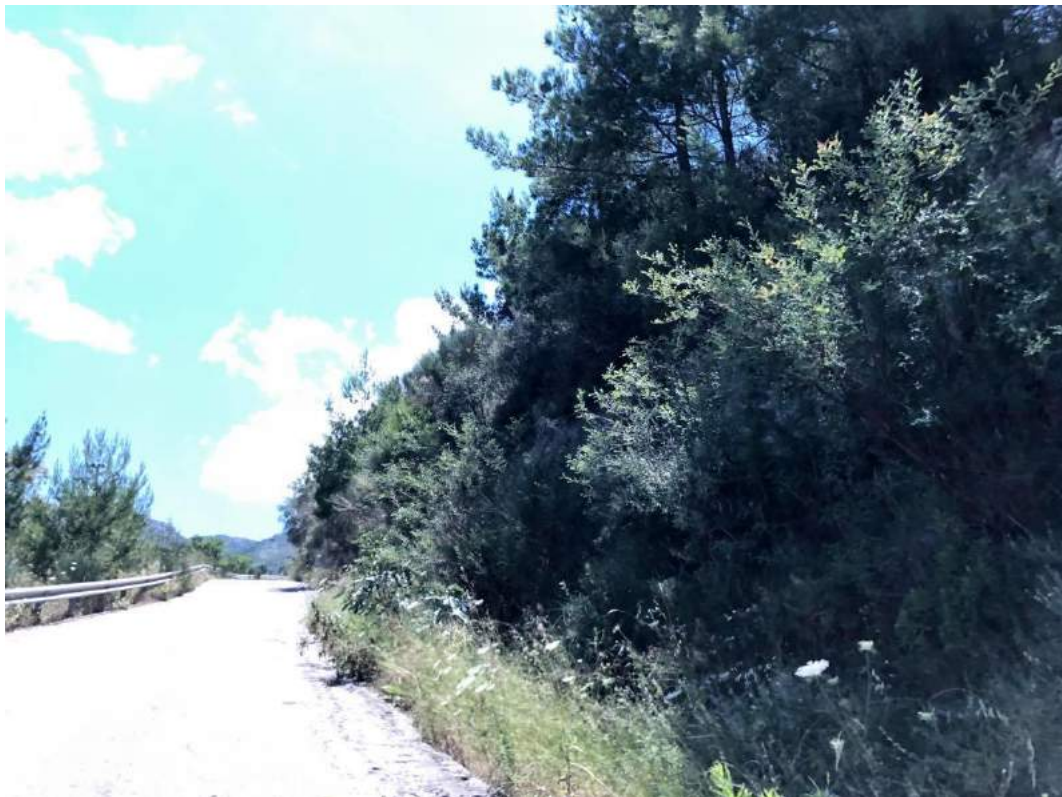
Εικόνα 65: Επαρχιακή Οδός Λευκάδας – Κάτω Εξάνθειας - Περιοχή παράκαμψης
