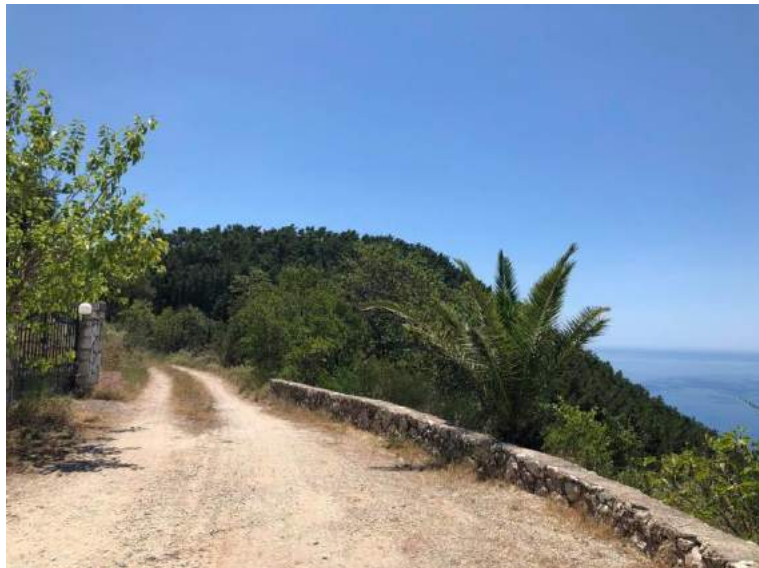
Εικόνα 76: Κατασκευή νέου τμήματος
