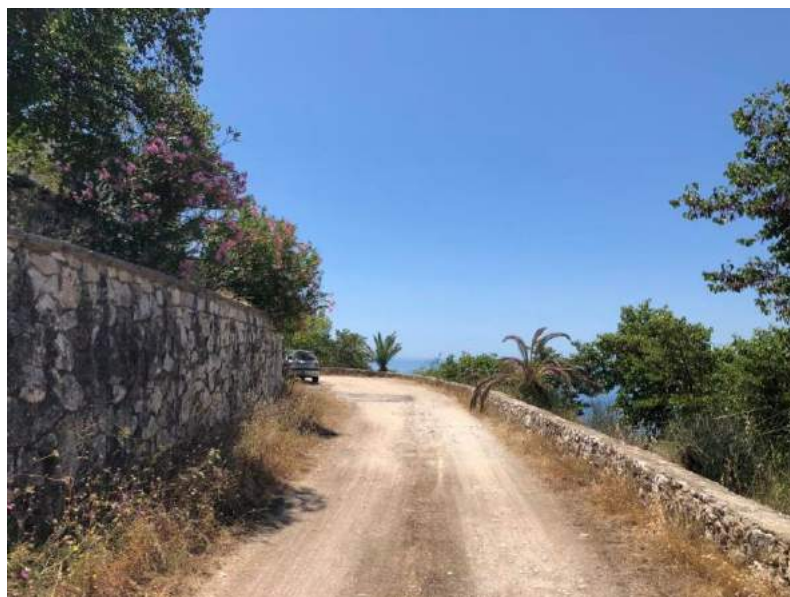
Εικόνα 74: Κατασκευή νέου τμήματος
