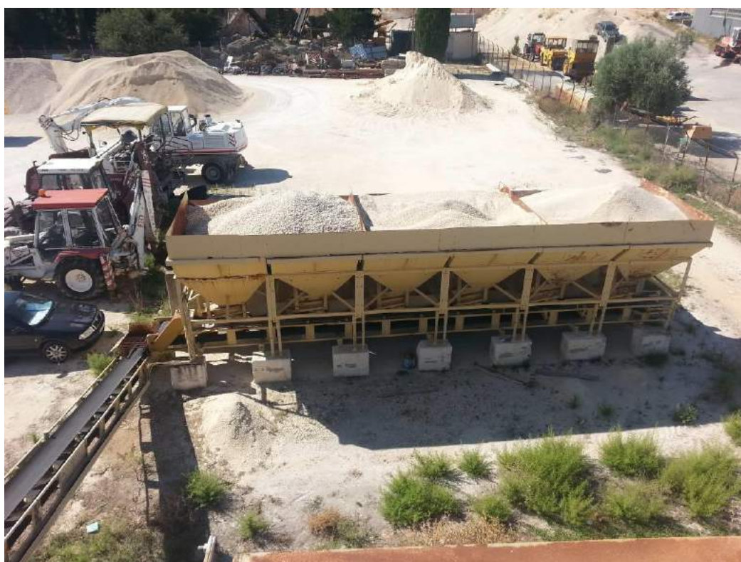
Εικόνα 14.5: Άποψη σιλό αδρανών υλικών και υπαίθριων χώρων αποθήκευσης αδρανών
