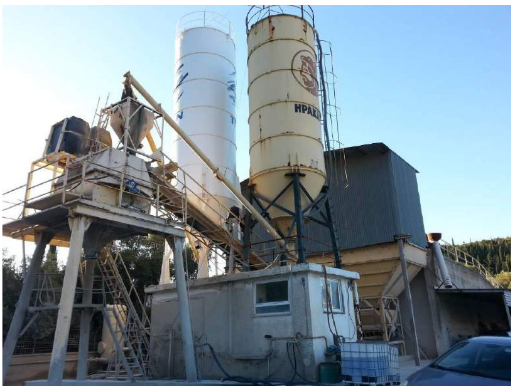
Εικόνα 14.8: Άποψη σιλό τσιμέντου και αναμκτήρα σκυροδέματος
