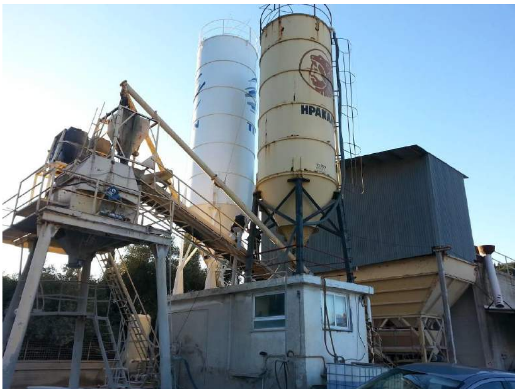
Εικόνα 14.7: Άποψη σιλό τσιμέντου και αναμκτήρα σκυροδέματος
