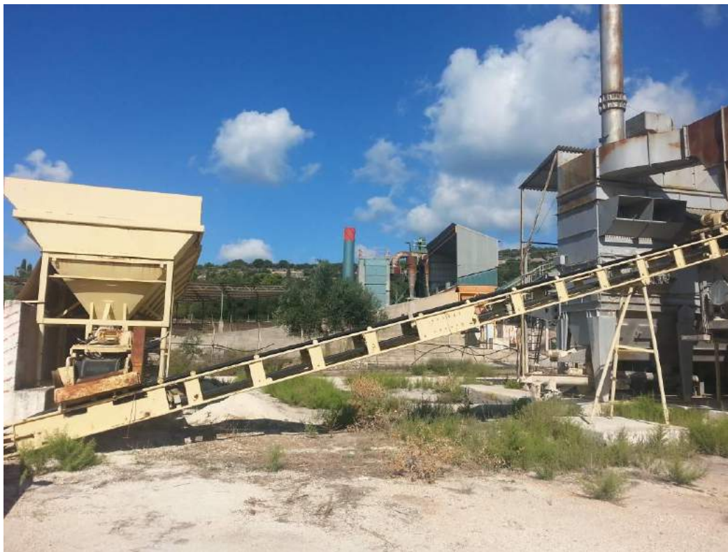
Εικόνα 14.4: Σιλό και μεταφορική ταινία αδρανών υλικών
