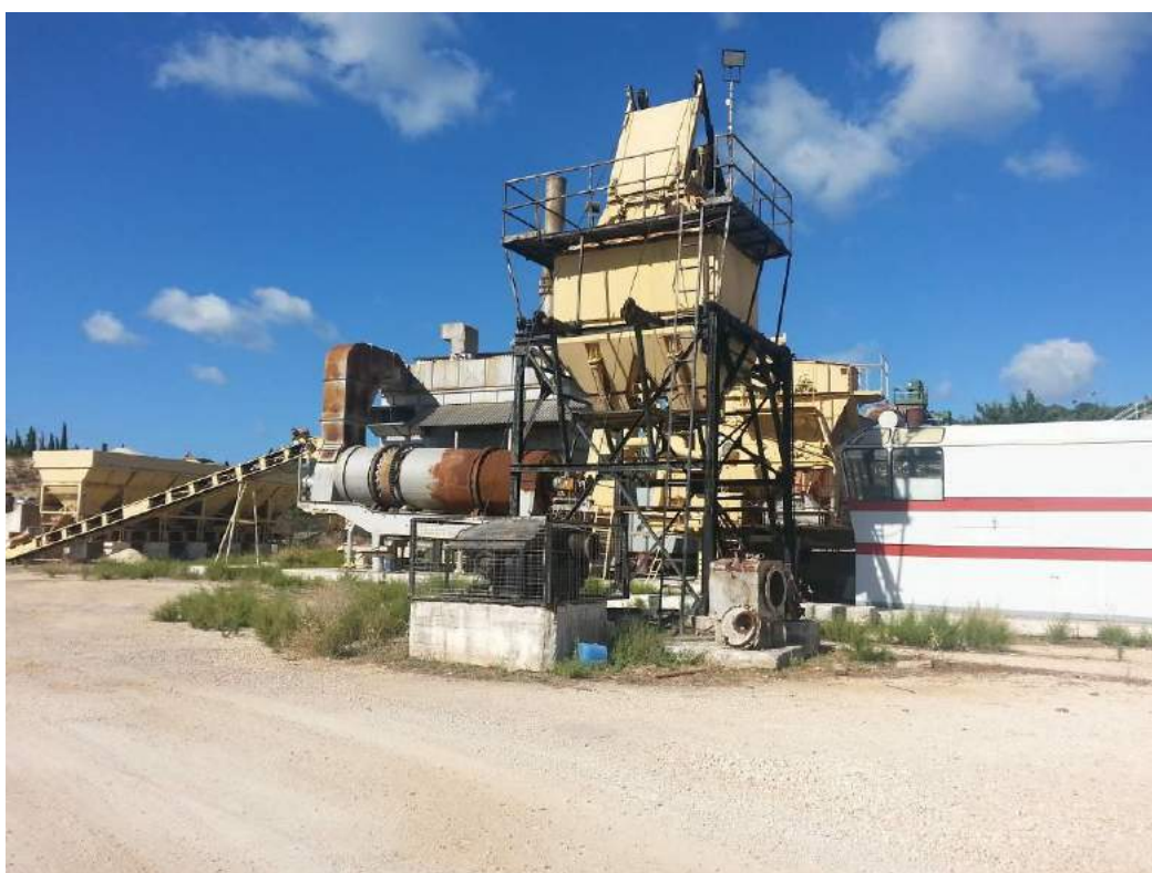
Εικόνα 14.3: Ανατολική όψη εγκατάστασης
