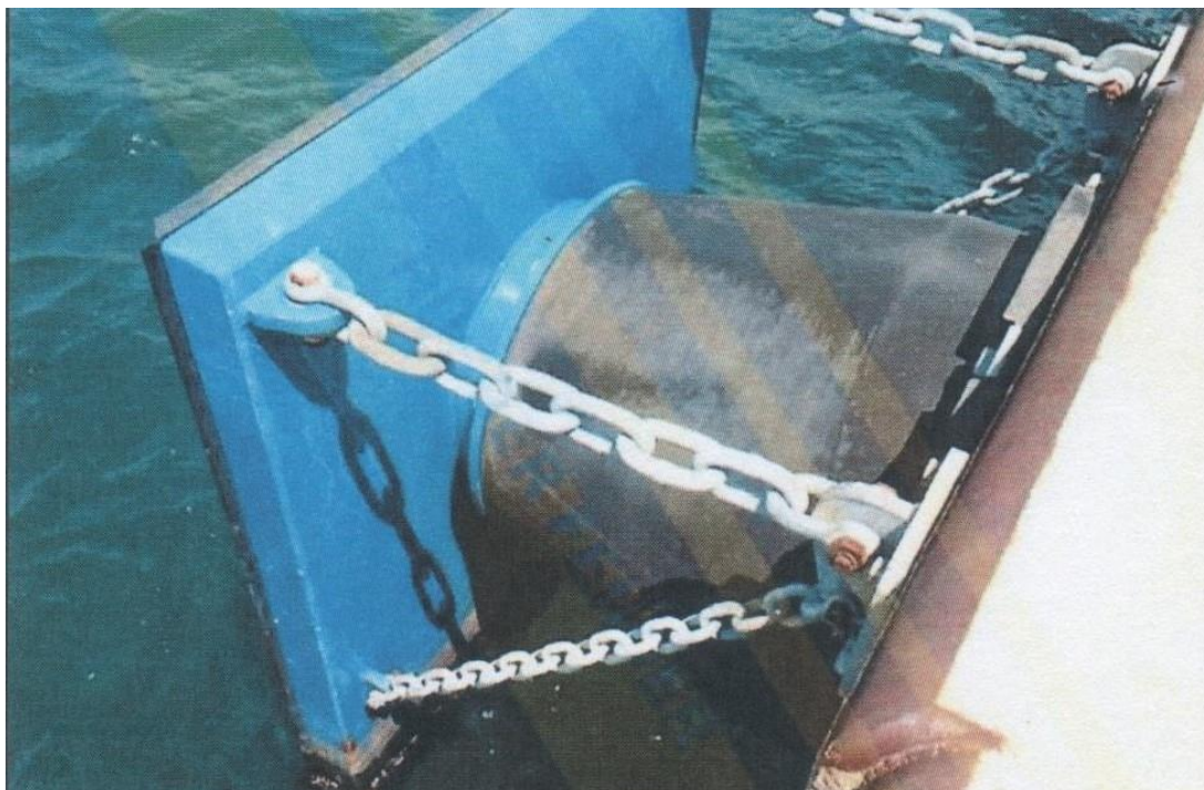
Εικόνα 2. Τυπικός ελαστικός προσκραυστήρας κωνικού τύπου
