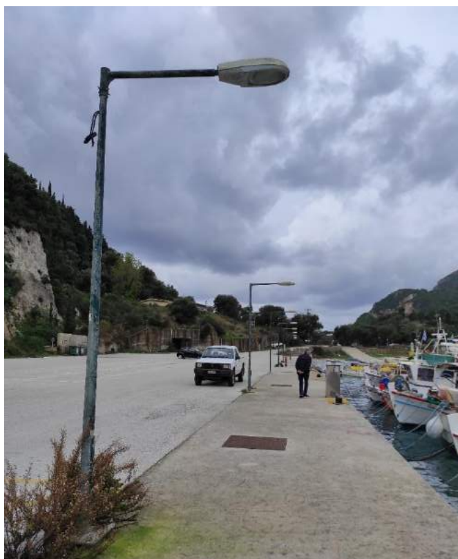
Φωτ. 2: Άποψη παραλιακού κρηπιδώματος
