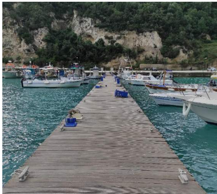
Φωτ. 5: Δέστρες πλωτού προβλήτα
