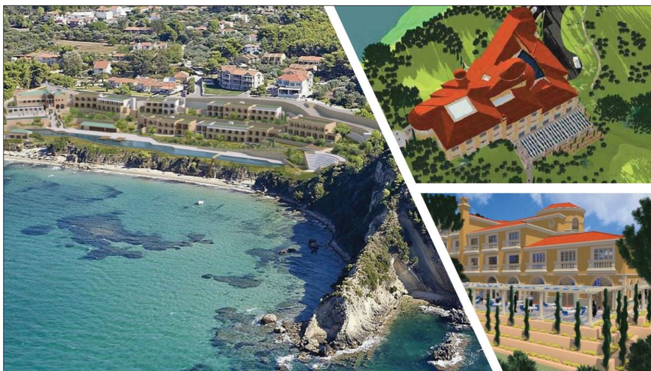
Σχήμα 7.7-1. Visual πρόταση της Εναλλακτικής λύσης Λ1, υλοποίησης του Έργου [3SK Stylianidis Architects, 2021].
