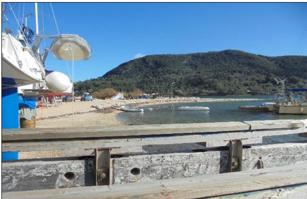
Εικόνα 37. Υπάρχουσα σχάρα ανέλκυσης και καθέλκυσης σκαφών
