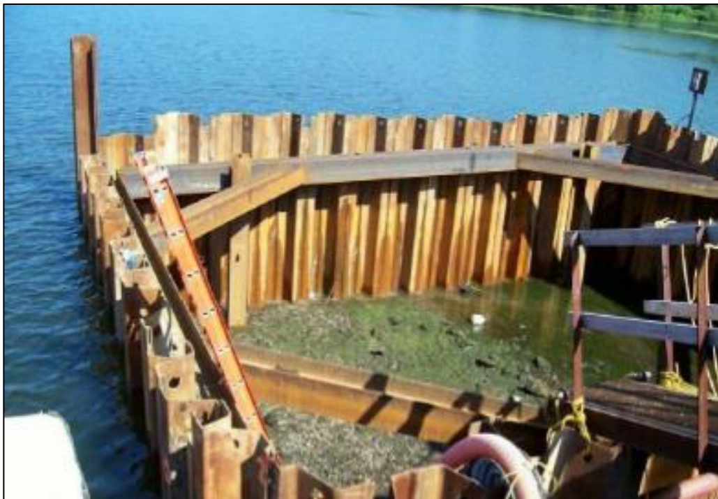
Εικόνα 9. Χρήση πασσαλοσανίδων μέσα στην θάλασσα
