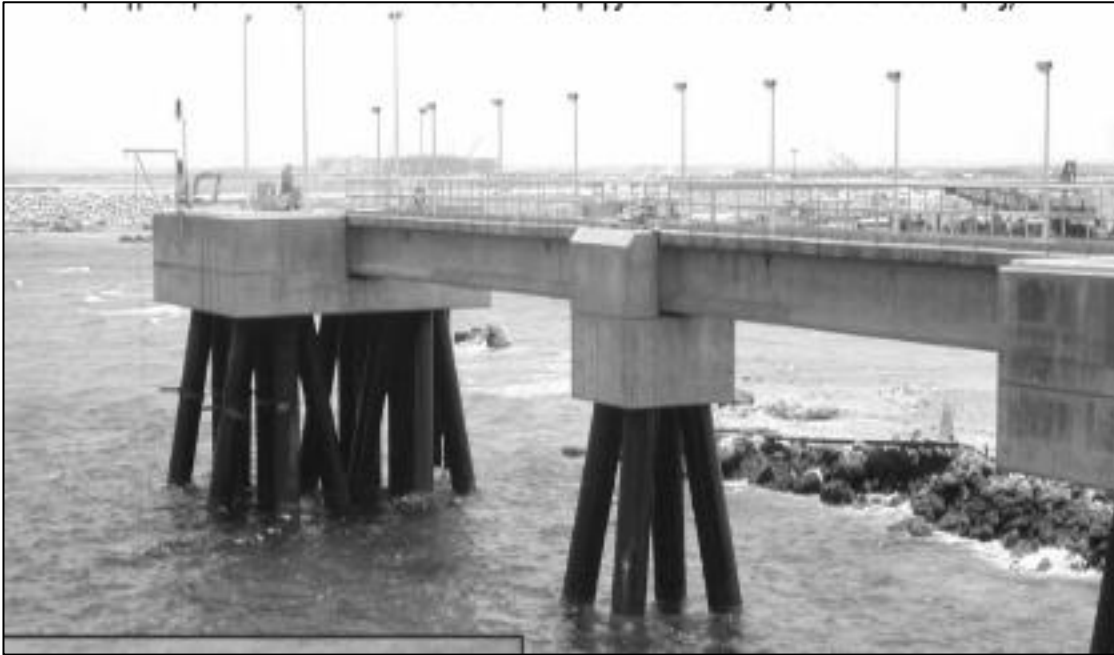
Εικόνα 10. Κατασκευή ανωδομής από πασσάλους
