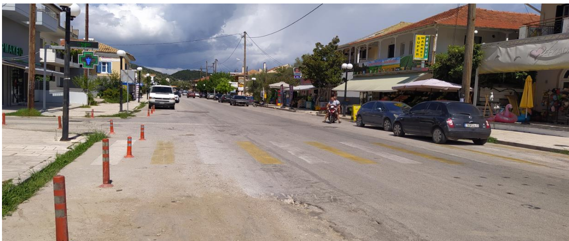
Διάβαση πεζών στη συμβολή ΧΘ 0+693 έχουν ληφθεί πρόσθετα μέτρα με χρωματική εναλλαγή και εύκαμπτα κολωνάκια για την απαγόρευση στάθμευσης
