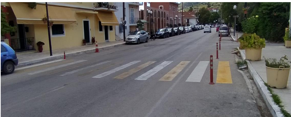
Διάβαση πεζών στη συμβολή ΙΝ Μεταμόρφωσης ΧΘ 0+893 , έχουν ληφθεί πρόσθετα μέτρα με χρωματική εναλλαγή και εύκαμπτα κολωνάκια για την απαγόρευση στάθμευσης
