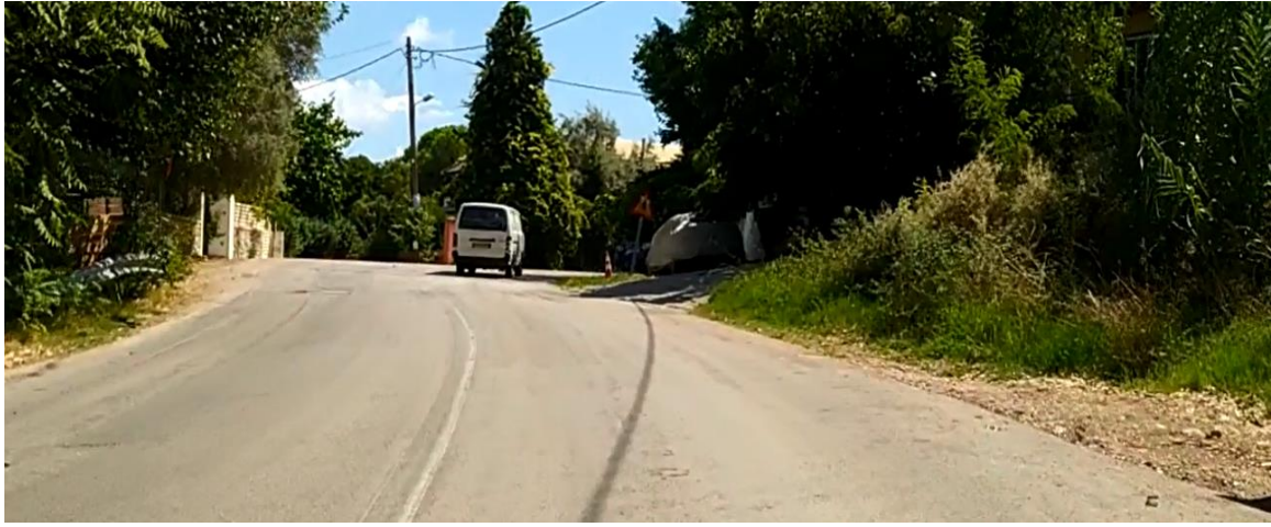
Άποψη της κλειστής καμπύλης περί τη ΧΘ 1+450 στη κατεύθυνση προς Νυδρί, διακρίνεται αριστερά το στηθαίο ασφαλείας.
