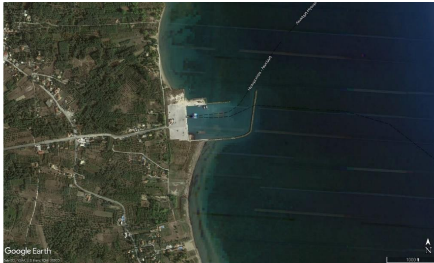
Σχήμα 6.3.2-3 Δορυφορική λήψη λιμένα Λευκίμμης και όμορων εκτάσεων (περίπου 10χλμ. ανατολικά της θέσης του έργου)
