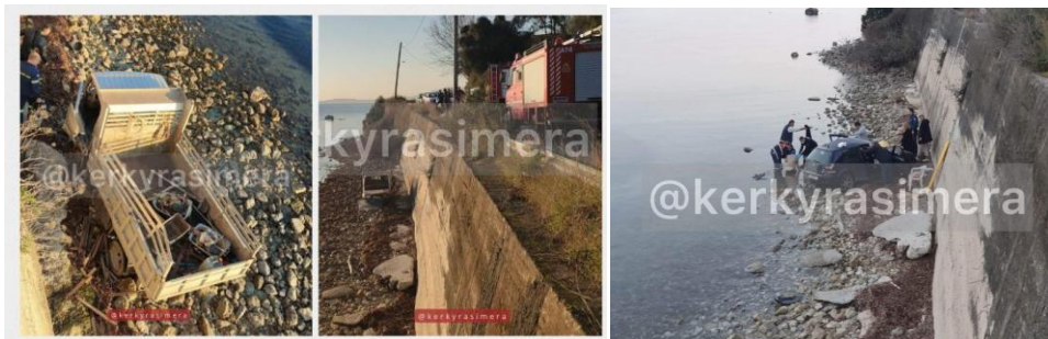
Εικόνες 1&2: Τροχαία ατυχήματα στη περιοχή της Γέφυρας Κάιζερ
