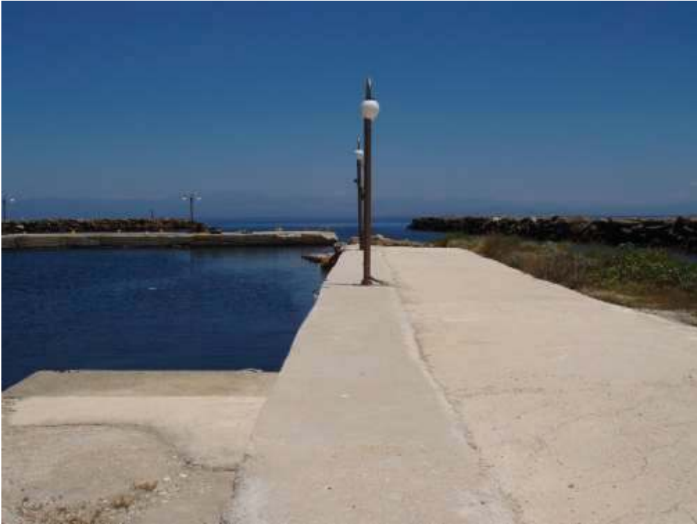
Φωτογραφία 5: Νότιο παραλιακό κρηπίδωμα
