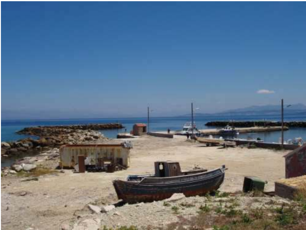
Φωτογραφία 1: Προσήνεμος μώλος λιμένα και βόρειος χερσαίος χώρος
