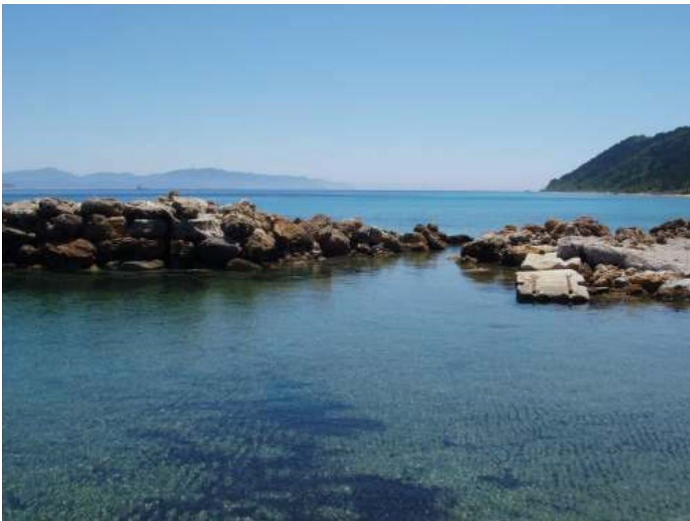
Φωτογραφία 3: Υπήνεμος μώλος – Άνοιγμα Για ανανέωση υδάτων
