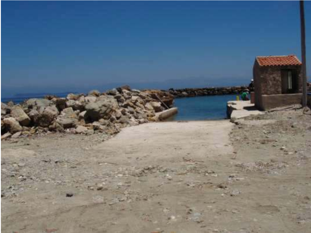
Φωτογραφία 9: Ράμπα ανέλκυσης/καθέλκυσης στη ρίζα του εσωτερικού προβλήτα
