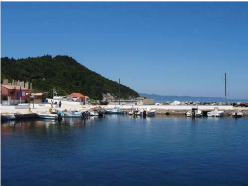
Φωτογραφία 6: Δυτικό παραλιακό κρηπίδωμα
