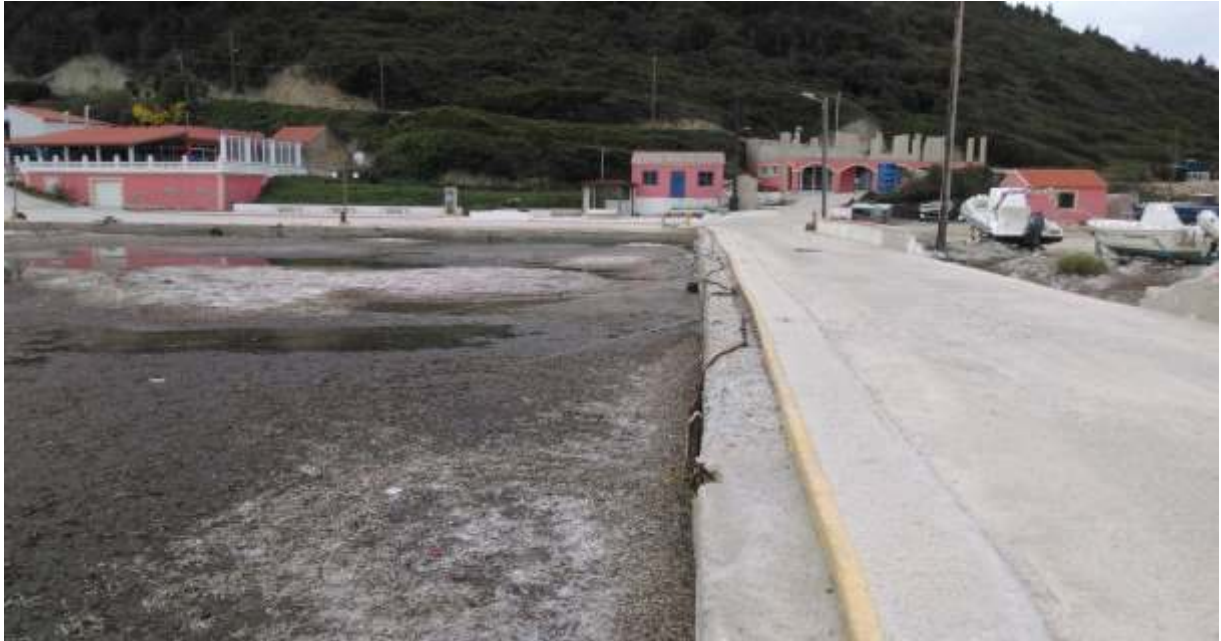
Φωτογραφία 11: Προσάμμωση και προσφύκωση της εσωτερικής λιμενολεκάνης – κρηπιδώματα εγκάρσια στην παραλία (2015).
