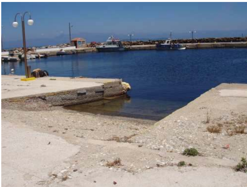
Φωτογραφία 8: Ράμπα ανέλκυσης/καθέλκυσης στη νότια γωνία των παραλιακών κρηπιδωμάτων
