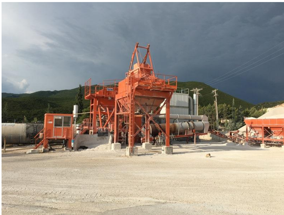
Απεικόνιση της υφιστάμενης μονάδας παραγωγής ασφαλτομίγματος
