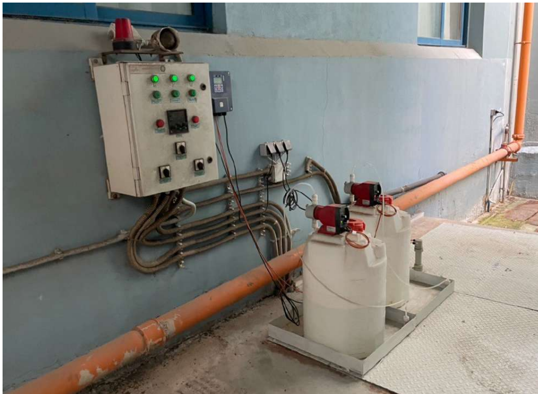
Εικόνα 12: Η διάταξη δόρθωσης του pH των υγρών αποβλήτων του Εργαστηριακού Τομέα.
