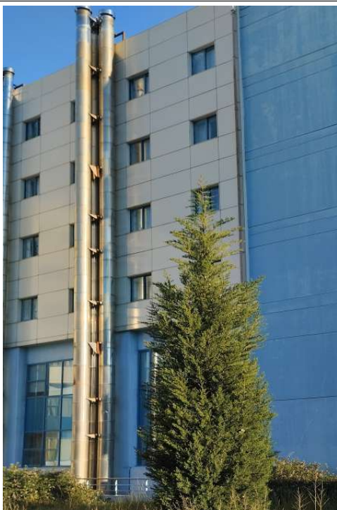
Εικόνα 9: Το σύστημα απαγωγής καυσαερίων (καμινάδες) του μηχανοστασίου/λεβητοστασίου
