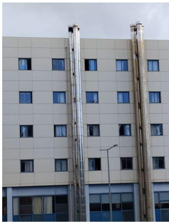
Εικόνα 9: Το σύστημα απαγωγής καυσαερίων (καμινάδες) του μηχανοστασίου/λεβητοστασίου
