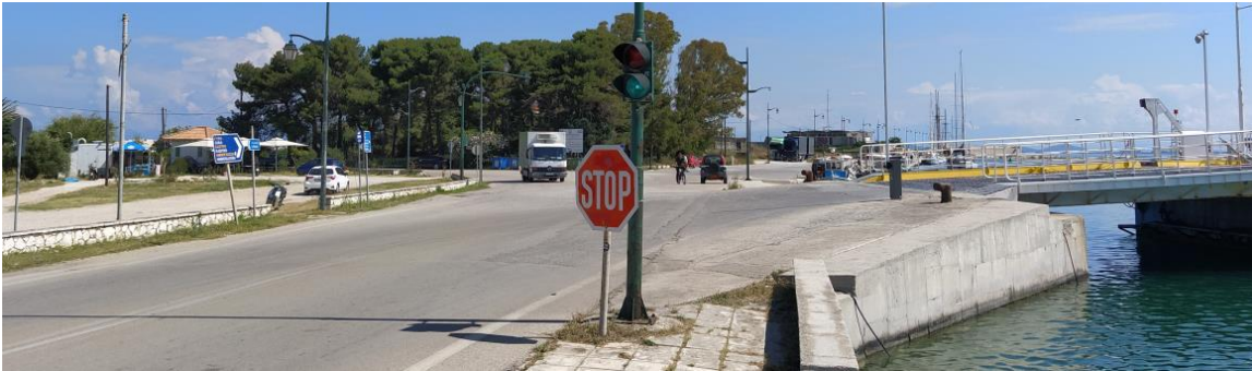
Φωτογραφία 14-1 Θέση Αρχής μελέτης ΧΘ 0+000 – Κινητή Γέφυρα και Κόμβος ΤΑΟΛ (38°50'39.54"Β, 20°43'2.93"Α)
