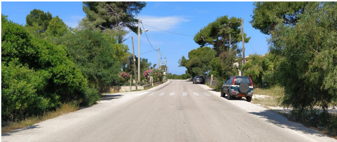
Φωτογραφία 14-4: Τμήμα στένωσης οδοστρώματος στη περιοχή Παναγιάς Γύρας (38°50'56.10"Β, 20°42'0.13"Α)
