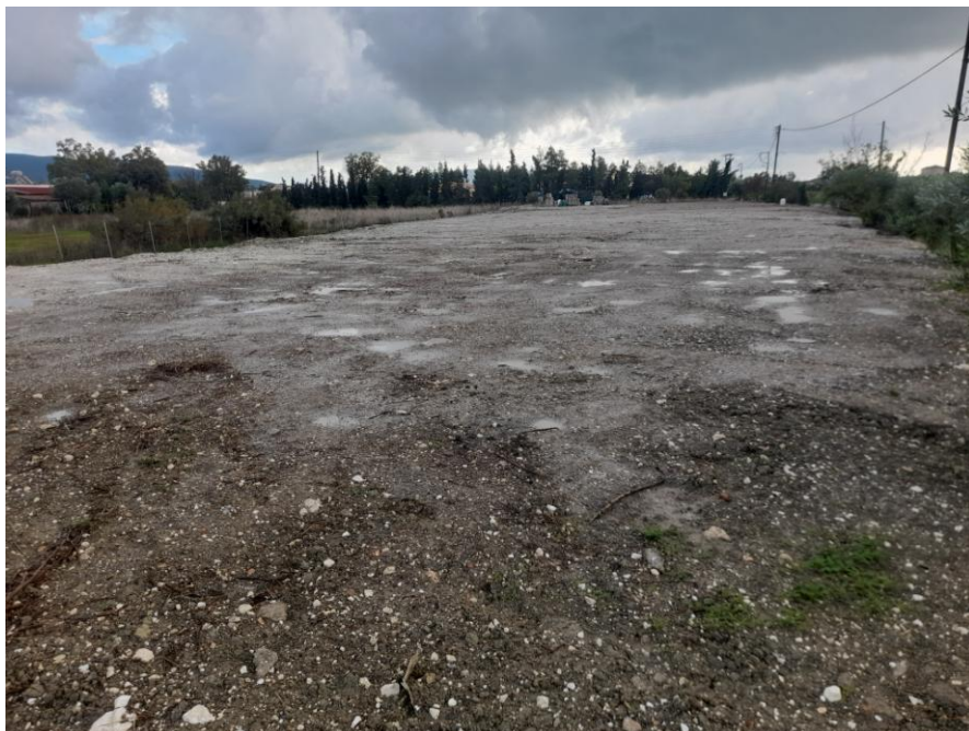
ΦΩΤ 9 μετά την απομάκρυνση
