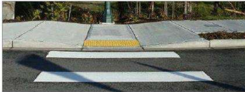
Σχήμα 7.3. Διαμόρφωση ράμπας για πλάτος πεζοδρομίου μικρότερο από 3,90μ.
