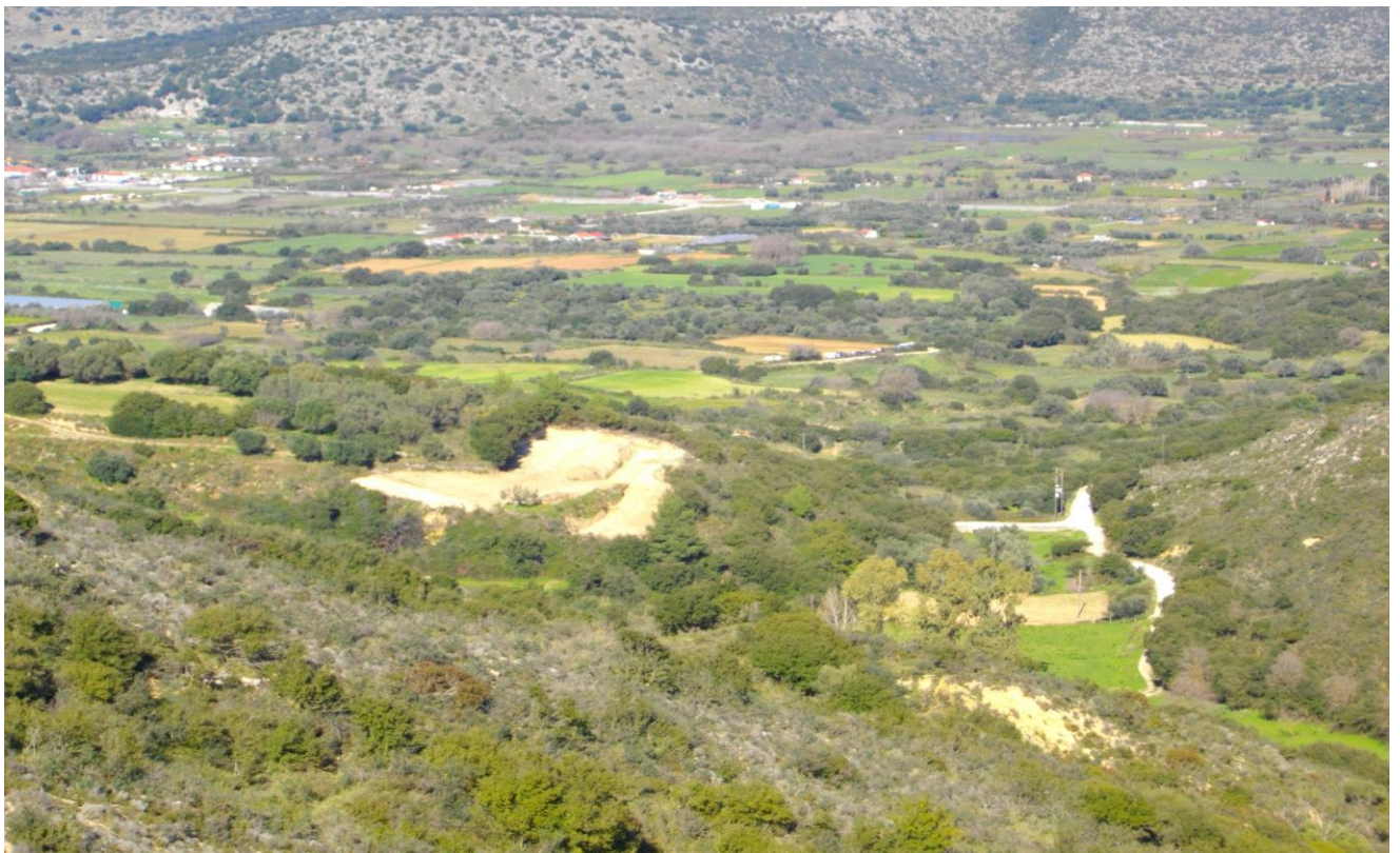
Εικόνα 10: Περιοχή γεφύρωση μισγάγγειας - Τμήμα ως πέρας χάραξης στον Ενδιάμεσο Κόμβο Δρόμου Κρανιάς.
