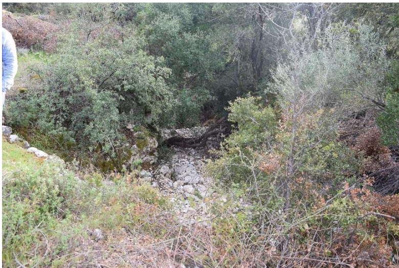
Φωτογραφίες θέσης κατασκευής προτεινόμενων νέων φραγμάτων
