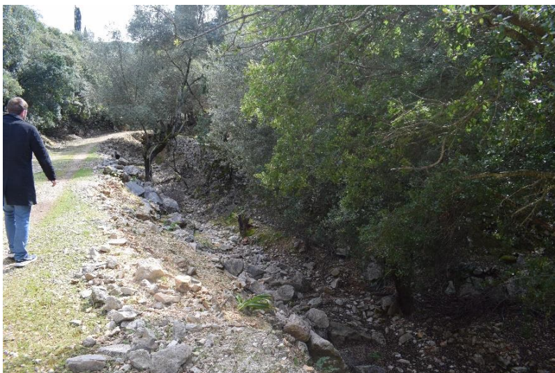
Φωτογραφίες θέσης κατασκευής προτεινόμενου νέου φράγματος
