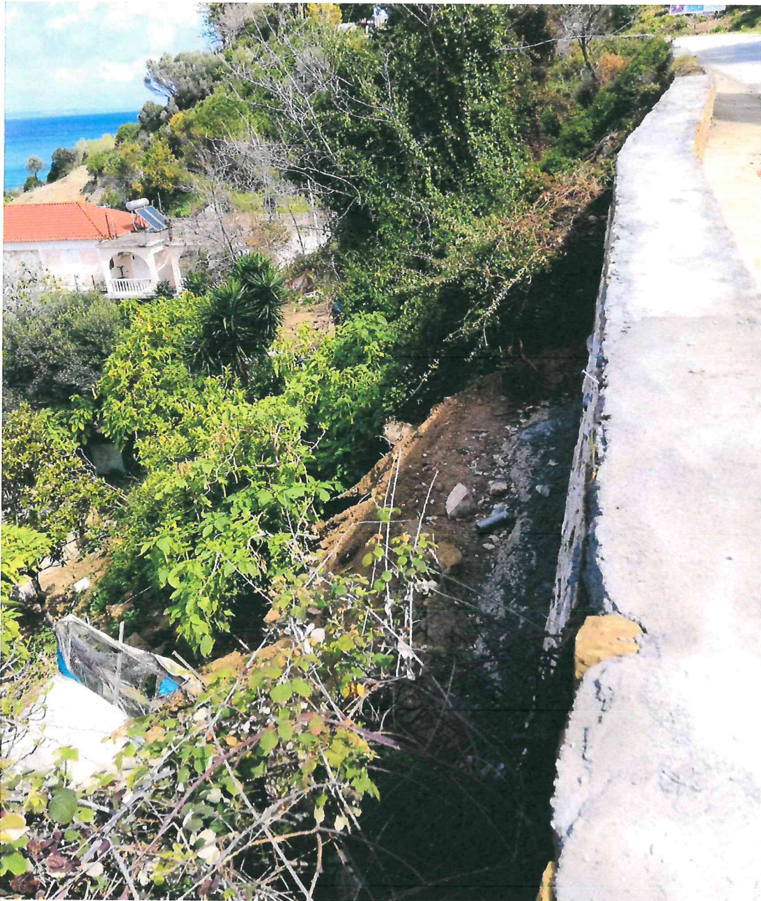
Η περιοχή του τοίχου και η κατάντη περιοχή όπου διακρίνονται οι υφιστάμενες οικίες, η έντονη Βλάστηση και το υπό κλίση έδαφος στην έδραση του τοίχου
