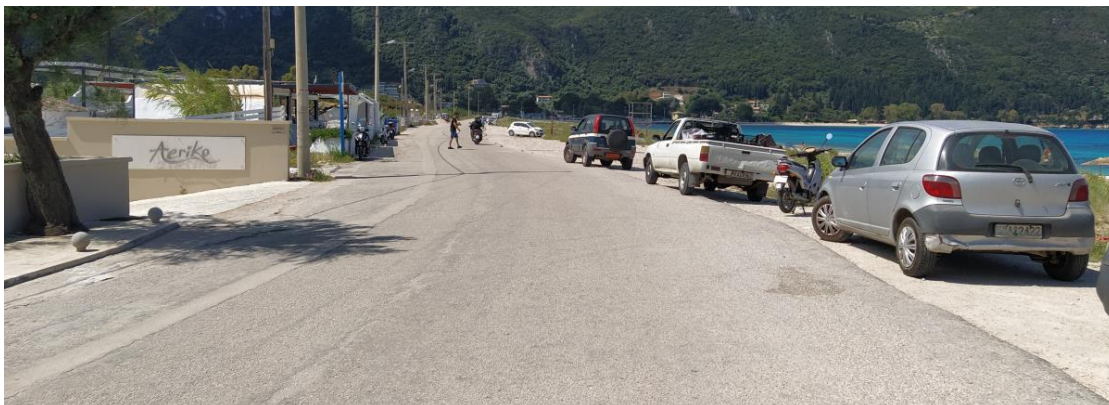
Φωτογραφία 14: Άποψη της υφιστάμενης οδού από τη ΧΘ 0+300 έως το πέρας. Διακρίνεται δεξιά η στάθμευση επί του ερείσματος και η απουσία χώρου για τη κυκλοφορία πεζών
