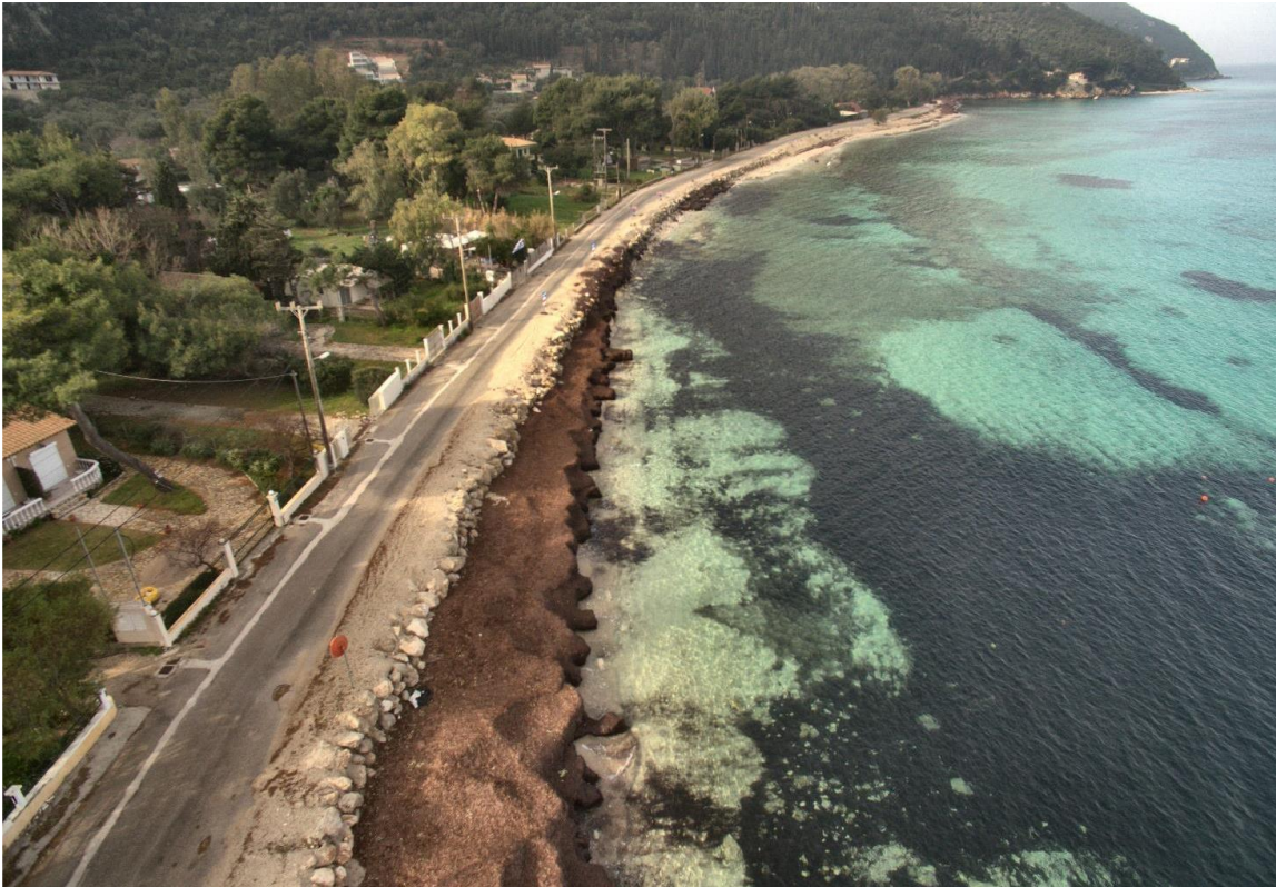
Φωτογραφία 4: Άποψη παράκτιου δρόμου/θωράκισης προς βορειοδυτικά
