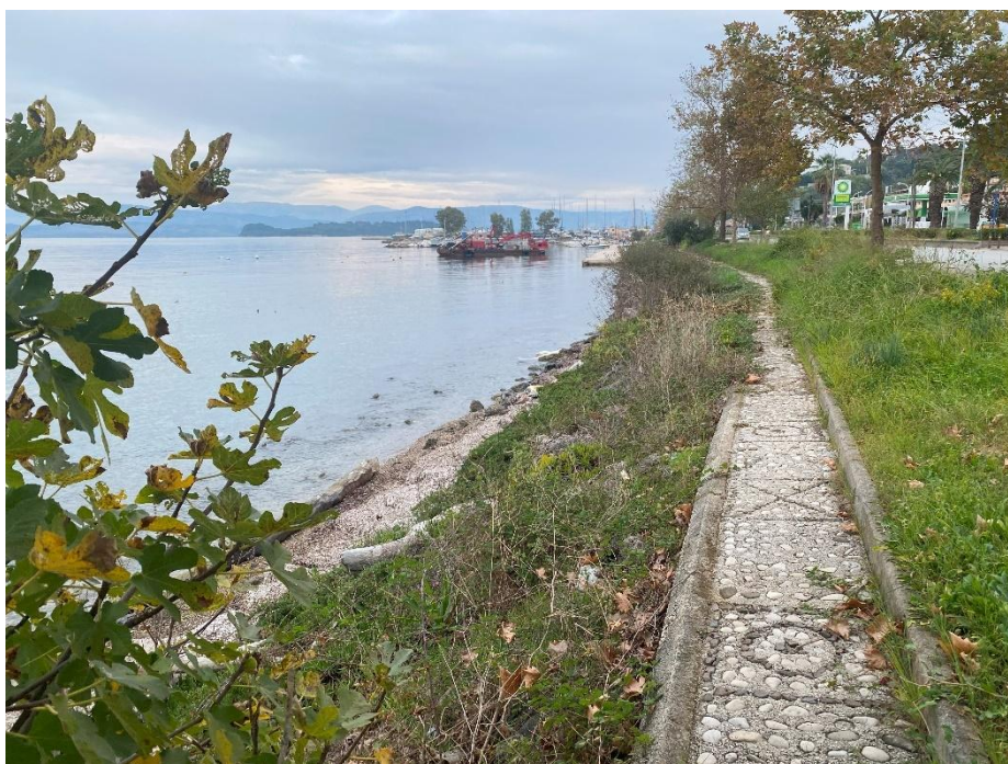
Φωτ. 4: Άποψη τμήματος πάνω από την ακτή, όμορου του ελεύθερου χώρου στάθμευσης
