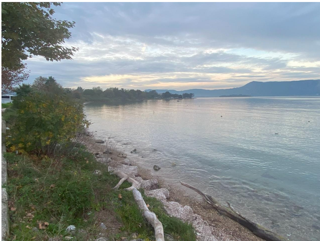
Φωτ. 3: Άποψη τμήματος της ακτής του Όρμου Ποταμού
