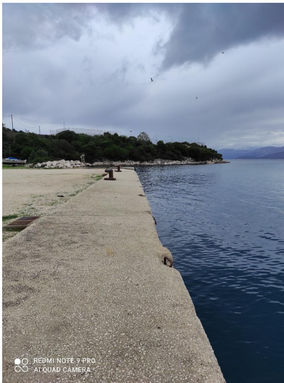
Φωτ. 3: Άποψη του ανατολικού μετώπου του υφιστάμενου προβλήτα, της παραλιακής θωράκισης προστασίας στα βόρεια αυτού, καθώς και του φυσικού πρανούς σε συνέχεια αυτών.
