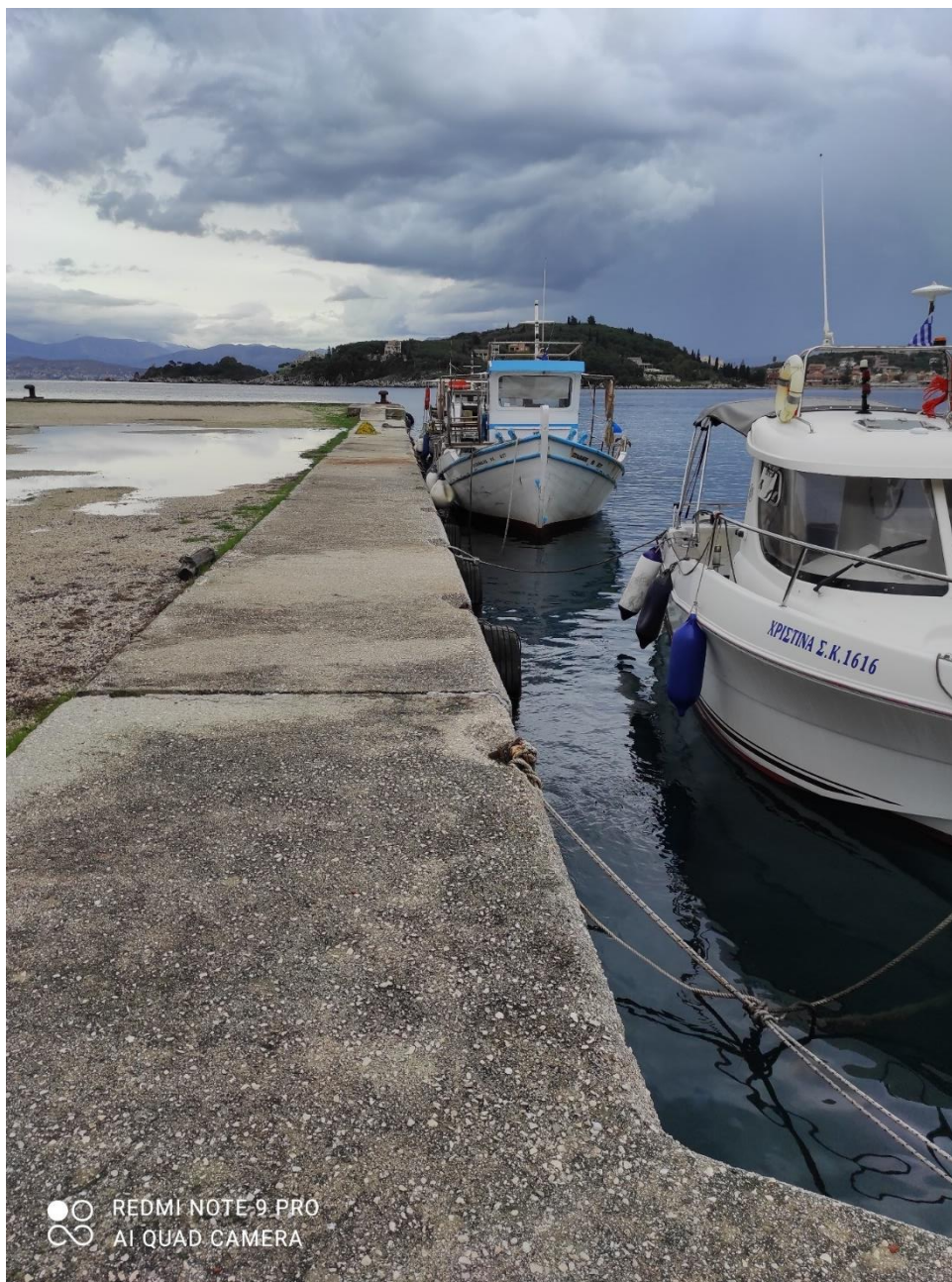
Φωτ. 2: Άποψη του νότιου και ανατολικού μετώπου του υφιστάμενου προβλήτα.
