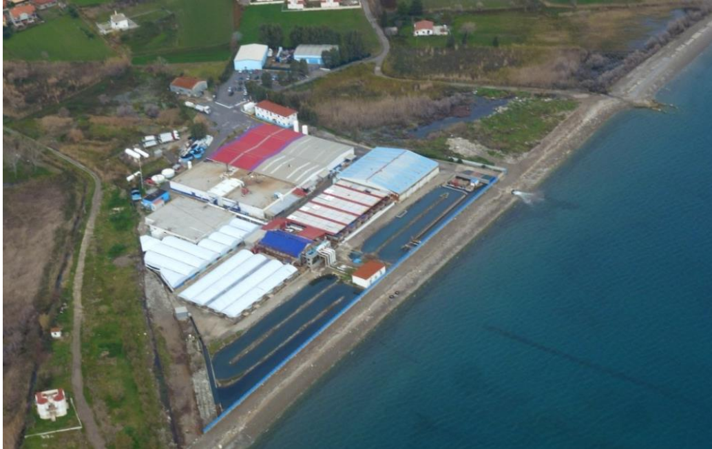
(Εγκαταστάσεις Ιχθυογεννητικού Χίλιαδου)
